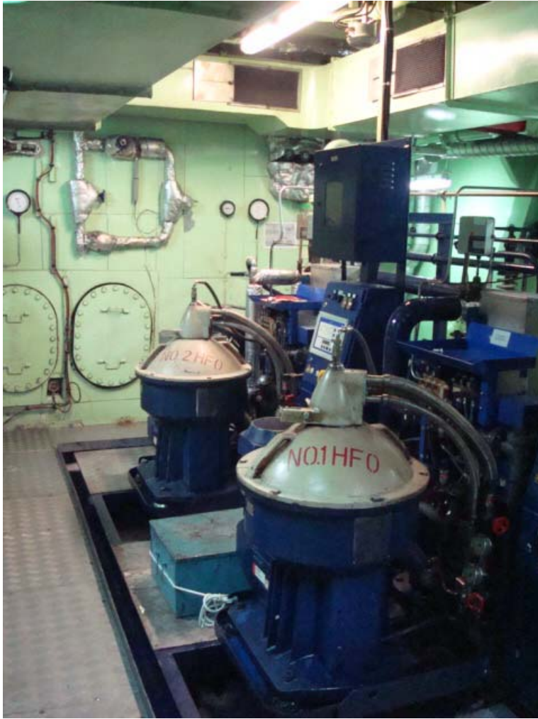
Kuva 16. Futuran raskasöljyseparaattorit
