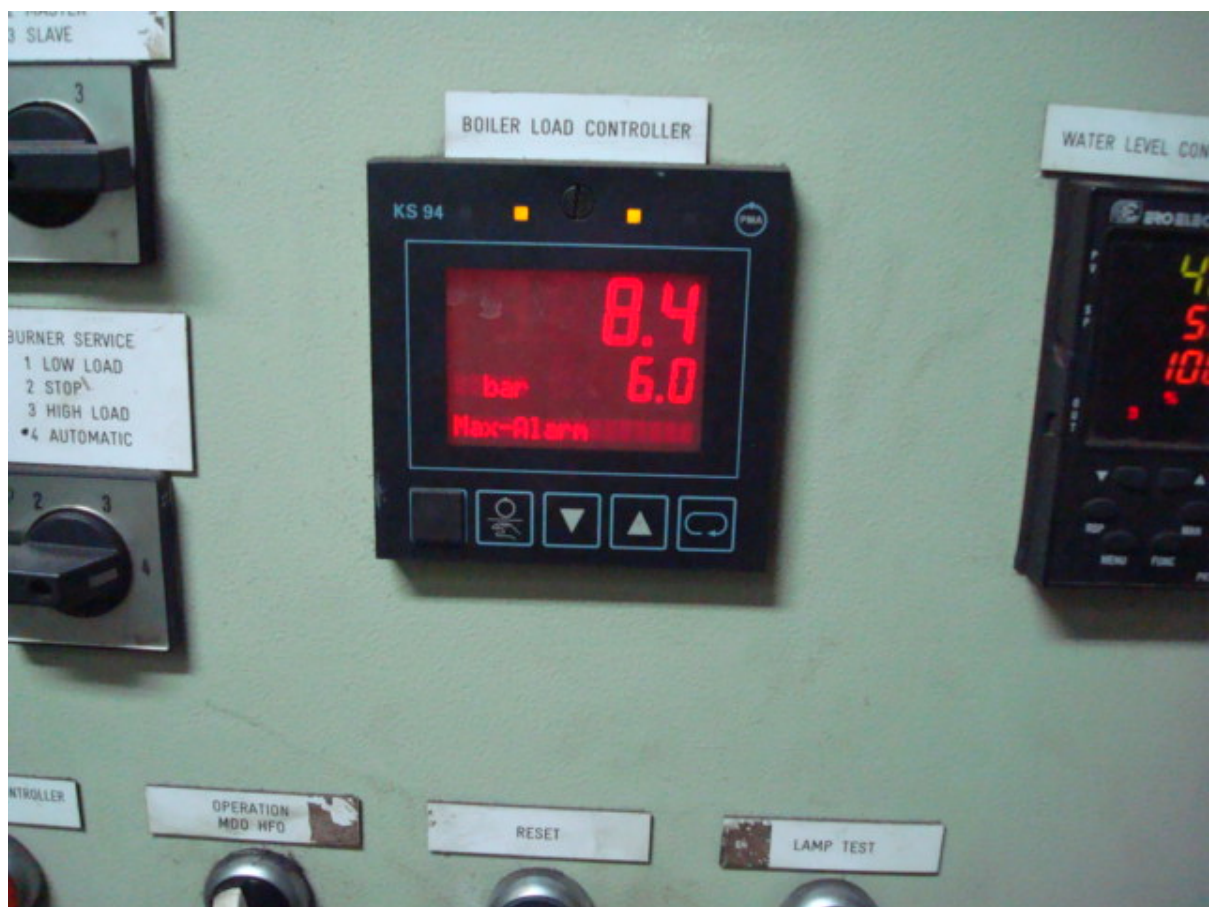
Kuva 15. Kattilan kuormanohjauspaneeli
