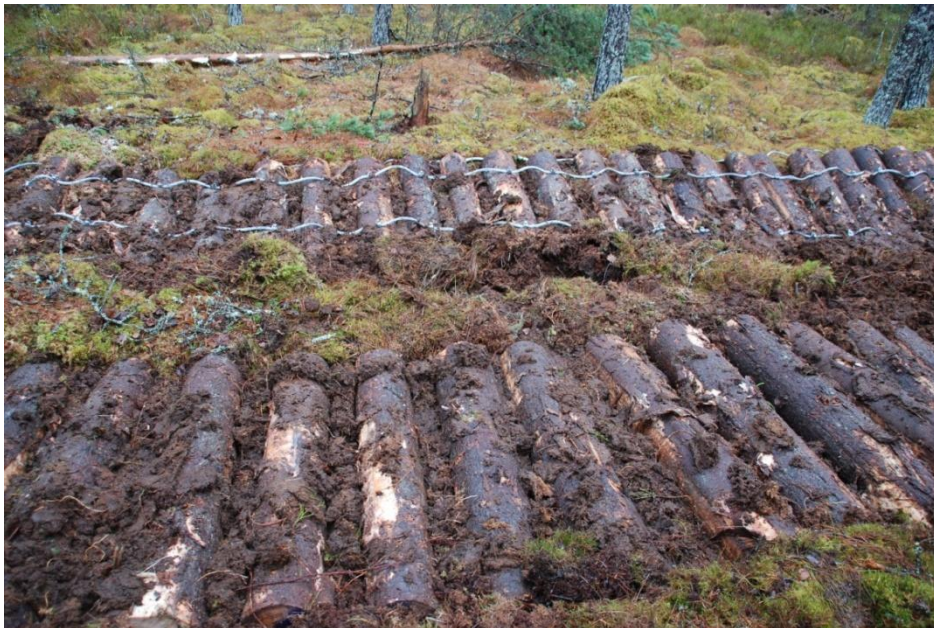
KUVA 9. Toinen matto vaijerit maata vasten ja toinen vaijerit ylöspäin
