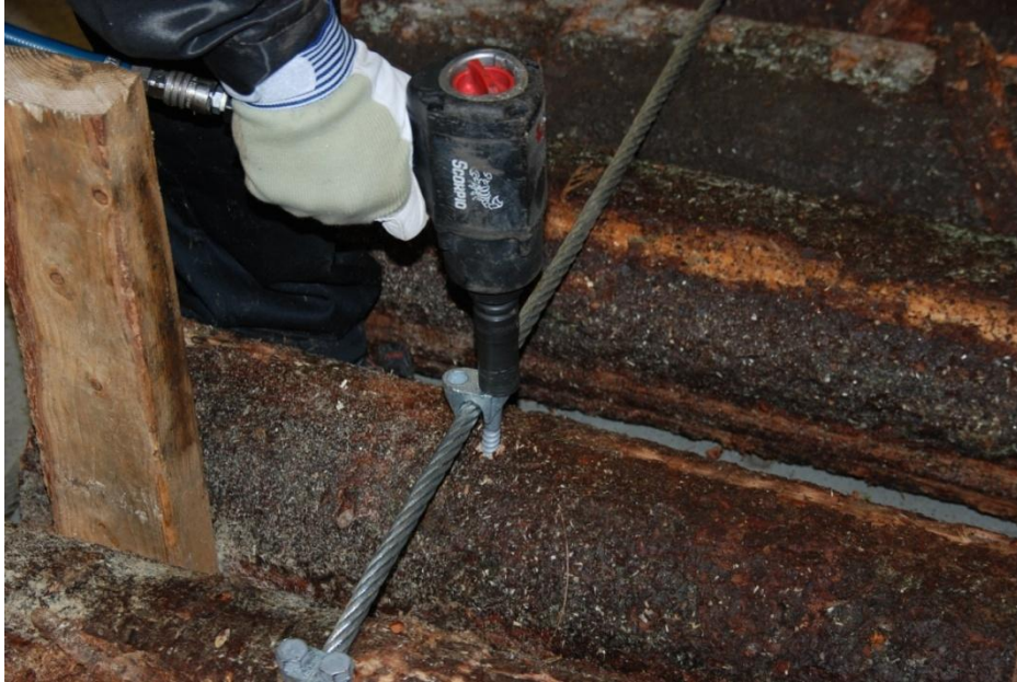
KUVA 6. Teräsvaijerin kiinnitys pölkkyyn
