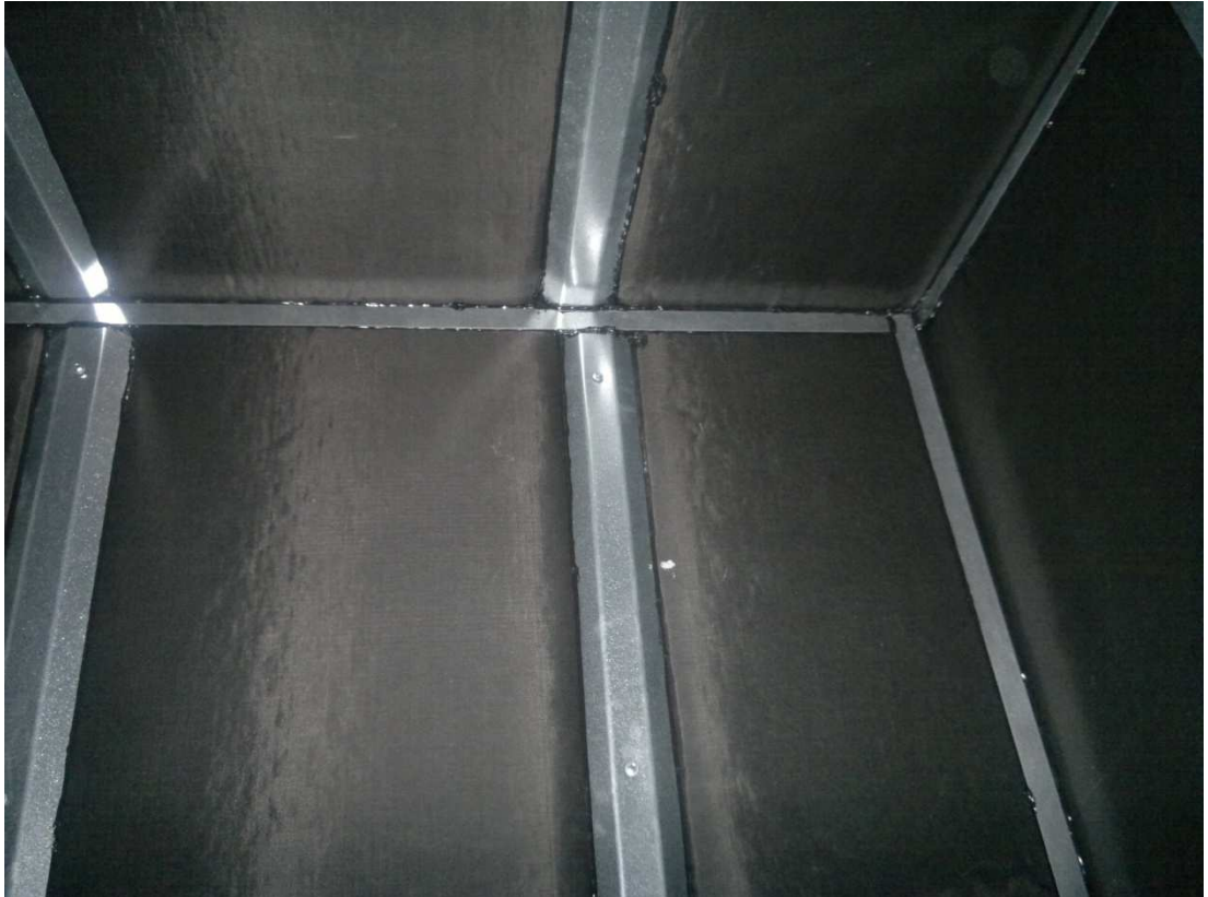
KUVA 2. Ilmanjakokammion eristys ja tiivistys oikein tehtynä
