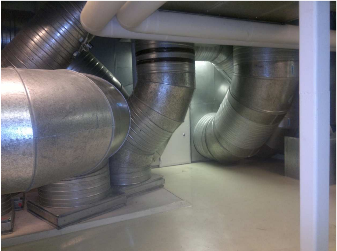
KUVA 3. Pyöreät kanavat
