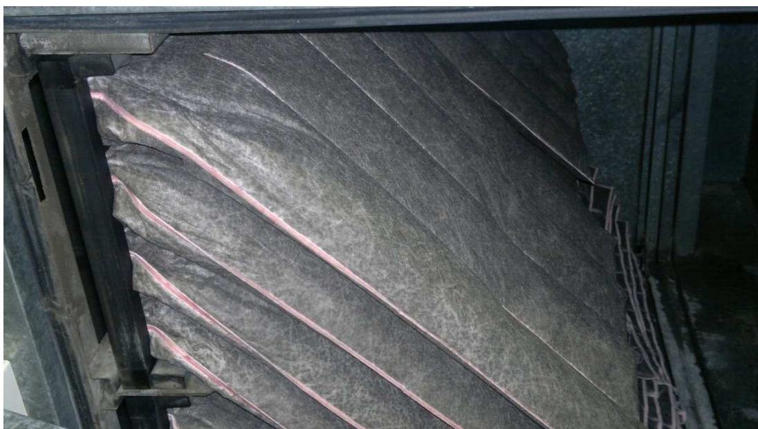
KUVA 8. Hienosuodatin F7
