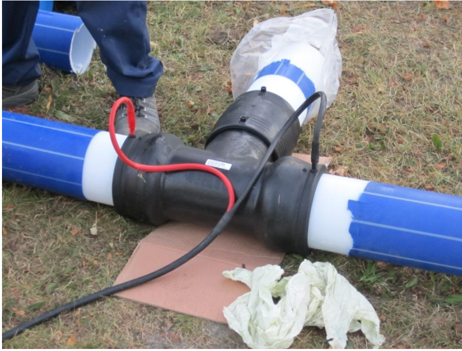
KUVA 32. Uponorin ProFuse -painevesijohtoon liitettävä T-liitoskappale hitsattavana Wredenkadun työmaalla. Työ tehdään kaivannon reunalla, josta yhdistelmä siirretään jäähtymisen jälkeen asennettavaksi kaivantoon; valokuva Juha Karppinen. Wredenkadun kiertoliittymätyömaa, Varkaus 2010.
