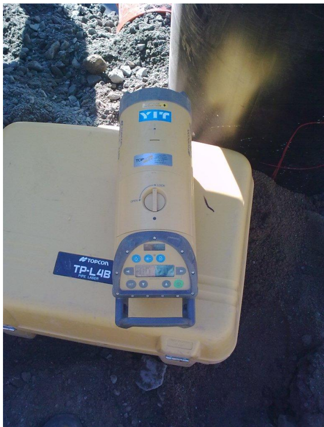
KUVA 34. Topcon -laser putkien vaai'itusta varten; valokuva Juha Karppinen. Wredenkadun kiertoliittymätyömaa, Varkaus 2010.
