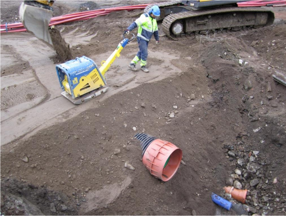
KUVA 12. Rakennekerroksen tiivistämistä. Kaivannossa näkyvät paineellinen vesijohto 200 mm (sininen), viemäriputki 250 mm ja hulevesiputki 560 mm; valokuva Juha Karppinen. Wredenkadun kiertoliittymätyömaa, Varkaus 2010.
