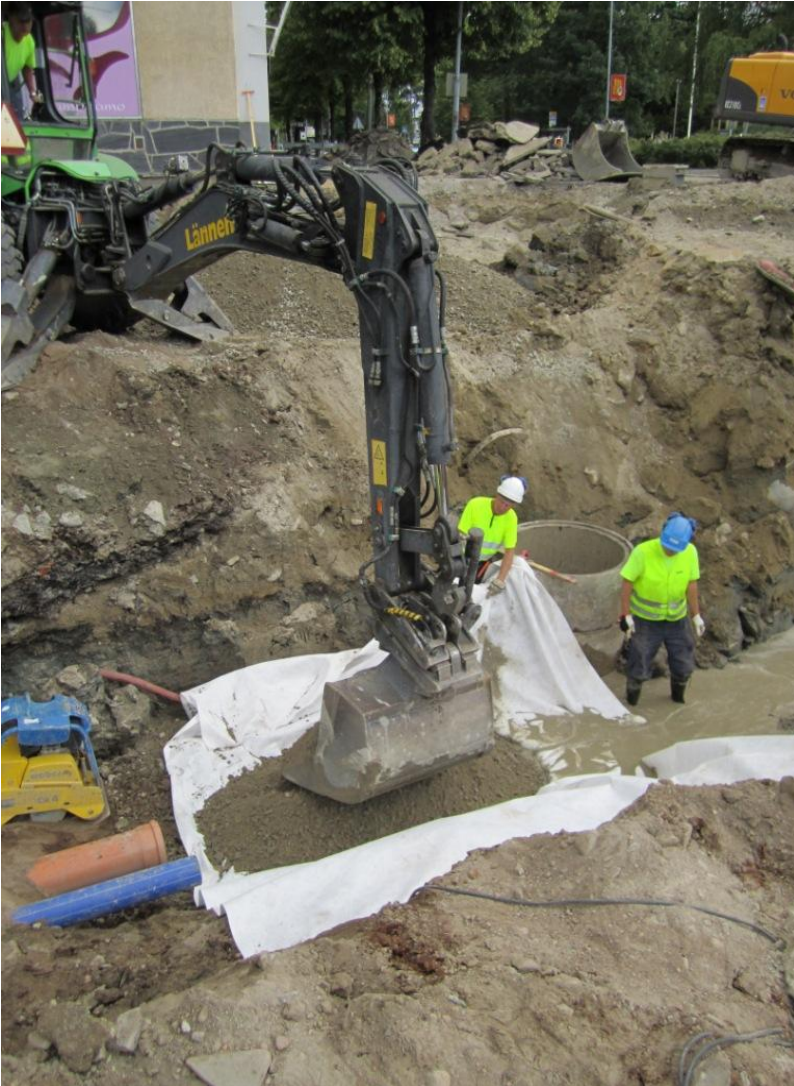
KUVA 27. Murskearinan vuoraminen suodatinkankaan sisään; valokuva Juha Karppinen. Wredenkadun kiertoliittymätyömaa, Varkaus 2010.
