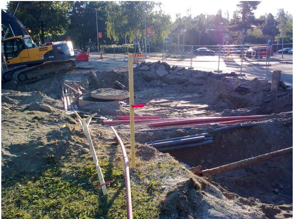
KUVA 5. Kaivutöitä kaapeliviidakossa. Kaivutöiden erityishaasteena olivat useat kadun alla sijainneet kaapelit ja johdot; valokuva Juha Karppinen. Wredenkadun kiertoliittymätyömaa, Varkaus 2010.
