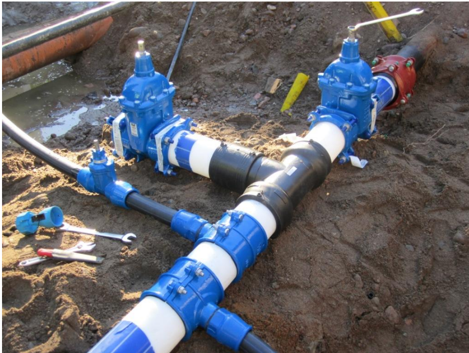
KUVA 33. Kuvassa 32 esitetty putki asennettuna kaivantoon. Putkeen on liitetty 63 mm:n tontti-vesijohtot venttiileineen sekä 160 mm:n venttiilit. Kuvan oikeassa yläkulmassa on vanhaan vesijohtoon (musta) yhdistetty uusi painevesijohto laajatoleranssiliitoksella (punainen); valokuva Juha Karppinen. Wredenkadun kiertoliittymätyömaa, Varkaus 2010.
