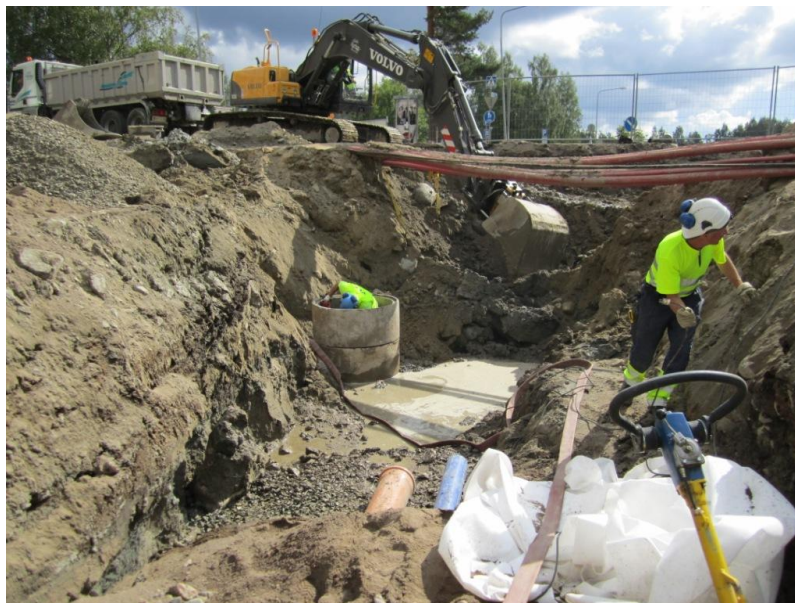
KUVA 29. Kaivannon kuivatusta. Pohjavettä pulppusi kaivantoon, minkä vuoksi kaivantoon tehtiin pieni syvennys johon laskettiin päällekkäin kaksi betonista kaivonrengasta. Vesi kerääntyi renkaiden sisään, josta se pumpattiin uppopumpun avulla pois kaivannosta; valokuva Juha Karppinen. Wredenkadun kiertoliittymätyömaa, Varkaus 2010.
