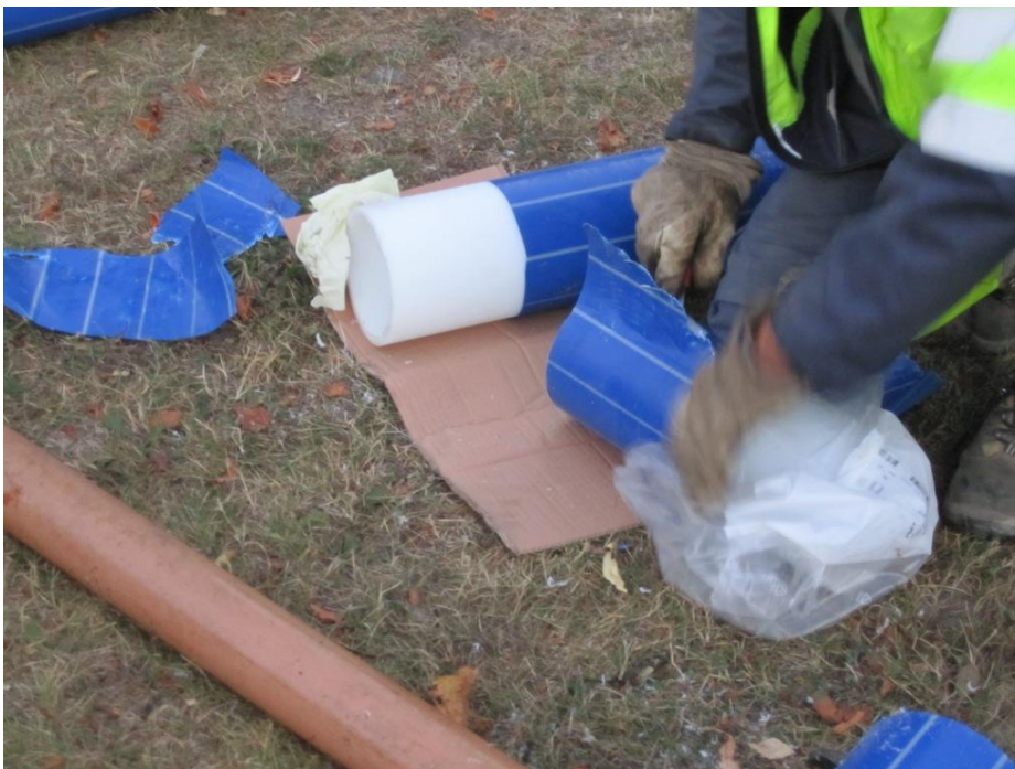
KUVA 31. Uponorin ProFuse -painevesijohdon kuorintaa Wredenkadun työmaalla. Putken sisähalkaisija on 160 mm. Kuorinta tehdään juuri ennen hitsaustyön aloittamista. Kuorinta tehdään tässä puukon avulla. Putkea peittävän suojakuoren ansiosta paljastettuna oleva putken pää on ollut suojassa hapettumiselta; valokuva Juha Karppinen. Wredenkadun kiertoliittymätyömaa, Varkaus 2010.
