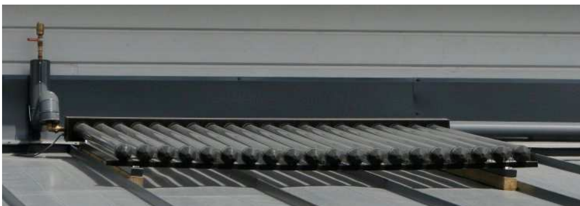
Kuva 20. Tyhjiöputkiaurinkokeräinelementti.
