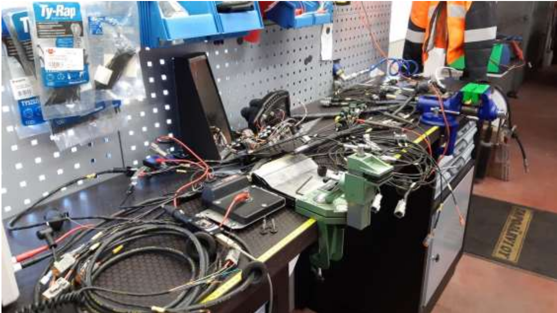
KUVA 13. Johtosarjojen testaus ennen asennusta
