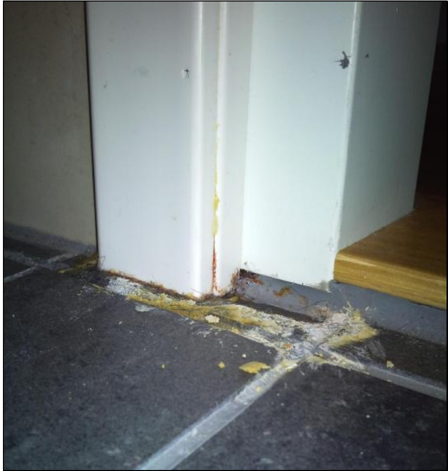
Kuva 3: Kylpyhuoneen oven vieressä, kylpyhuoneen puolella, on listan viereinen pieni laatan reunapala vahingossa mennyt vinoon ja ohjaa pienen määrän vettä listan juureen. Kun lista on päässyt kastumaan usein ja vesi jää seisomaan listan eteen, on aiheutunut pieni, mutta ikävän näköinen kosteusvaurio. Vaikka ongelma on pieni ja paikallinen, eikä se aiheuta suuria korjaustoimenpiteitä, on asiakkaan mielessä heti laaja, rakenteissa oleva kosteusvaurio ja vakava laatuongelma.
