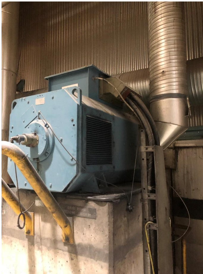
Kuvio 10. DC-moottorin jäähdytysilmasyöttö ja takometri
