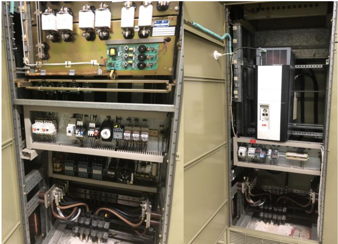
Kuvio 21. Alaviiran vetotelan vanha käyttö ja uusi retrofitit vierekkäin
