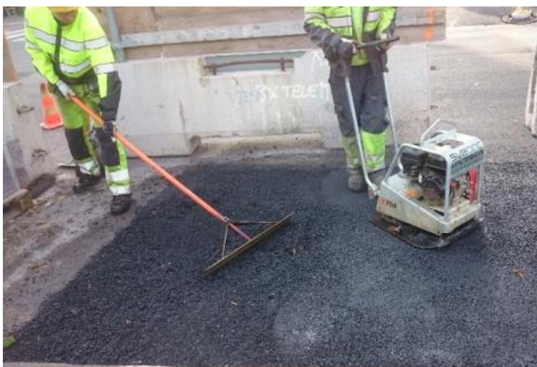
Kuva 3. PAB-paikkausmassan levitys käsityönä ja tiivistys tärvelyllä (Väylävirasto 2019c, 8)
