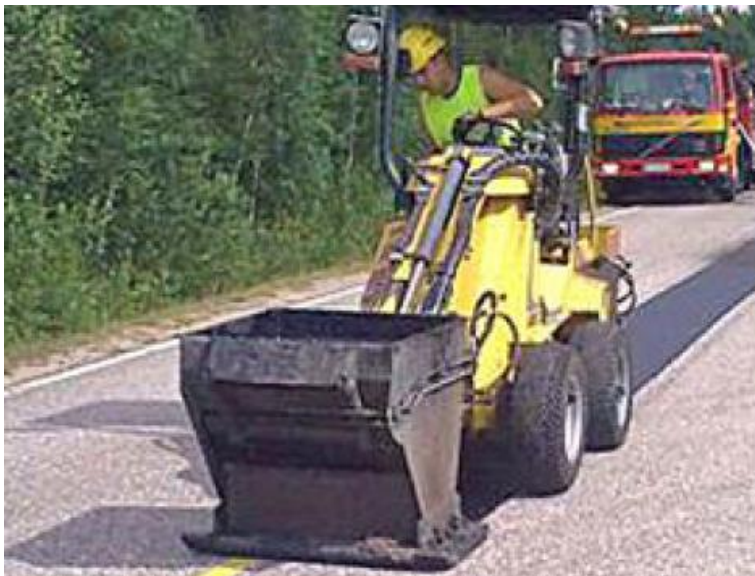
Kuva 5. Valuasfalttipaikkauksen levitys (Väylävirasto 2019c, 7)
