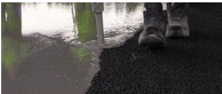
Kuva 8. Erikoislaastin levitys avoimen asfaltin päälle (NCC 2019b)
