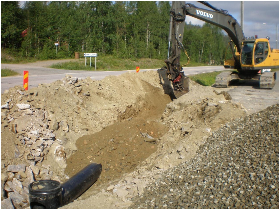
Kuvio 12. Sadevesiviemärin rakentaminen
