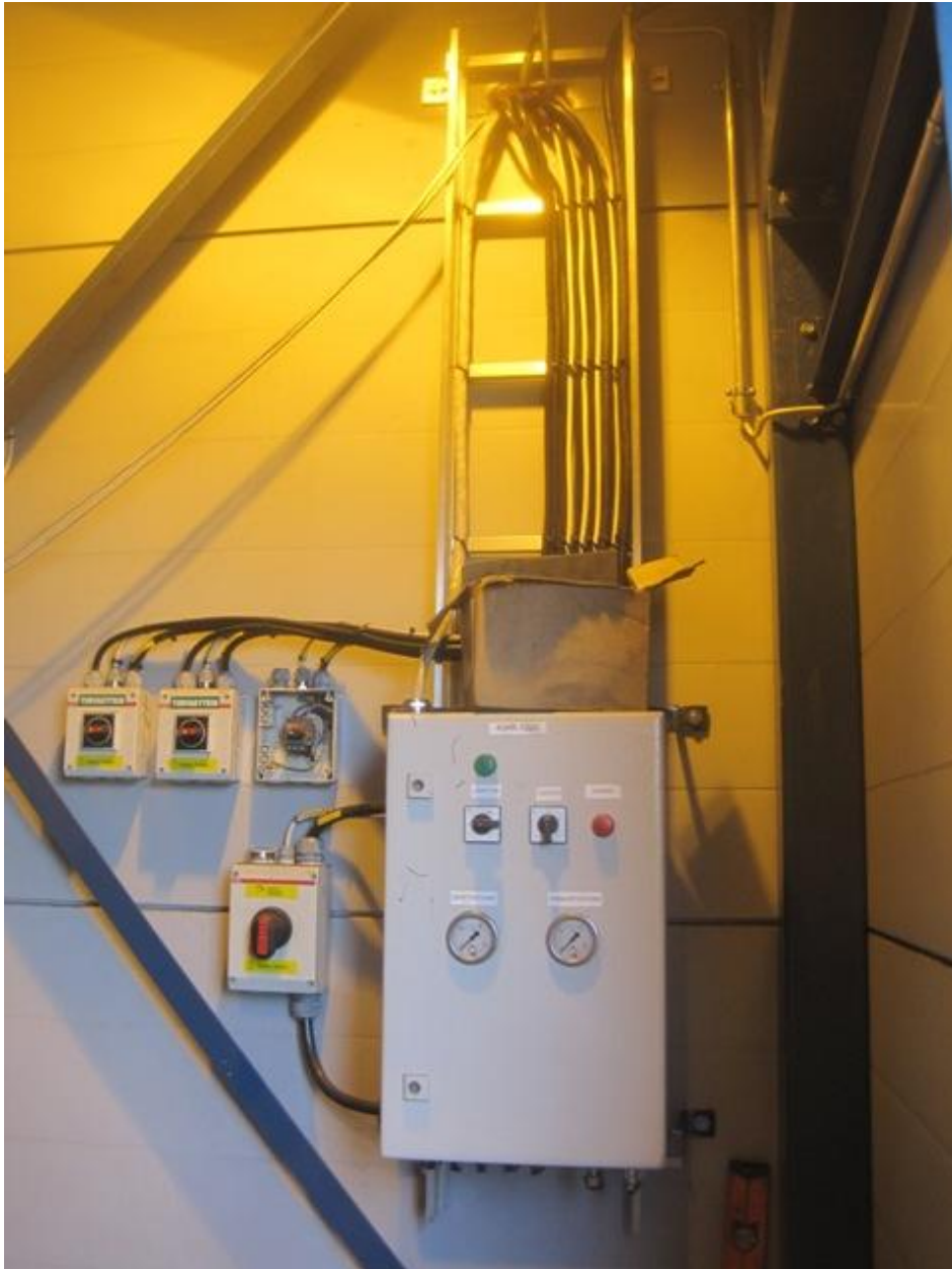
Kuva 11. Tykkihuoneen kaapelointi
