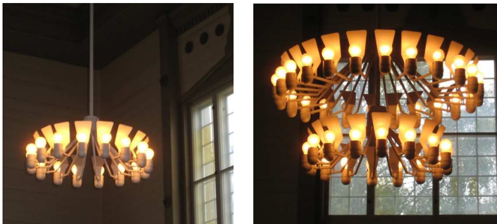
KUVA 15. Yksi- ja kaksitasoiset uudemmat kruunut, joissa lamppuina 40W himmeäkupuinen hehkulamppu E27 kannalla.
