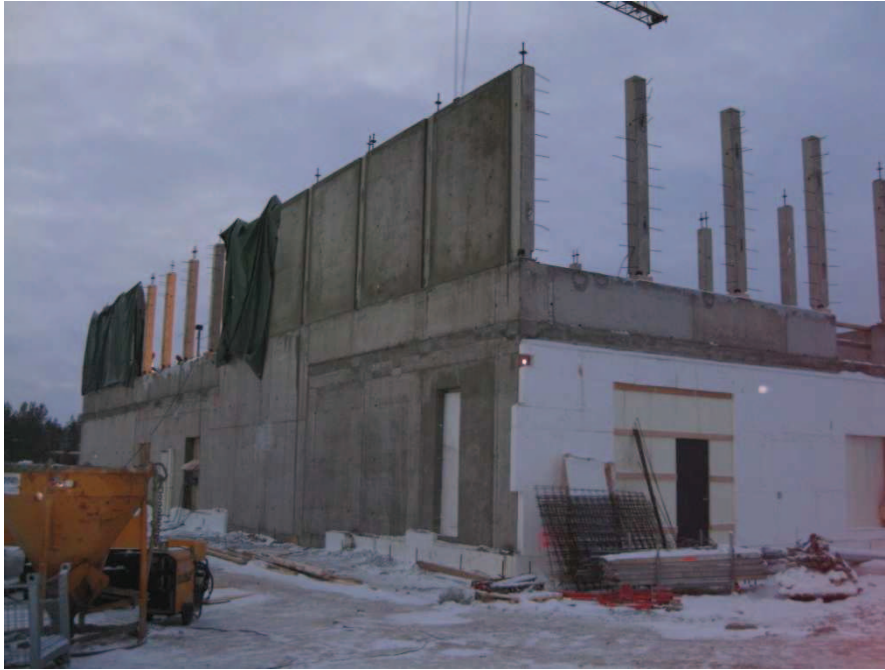
Figur 30. Väggarna som är gjutna täcks över för att inte värmen från värmeblåsaren går inte går till spillo.
