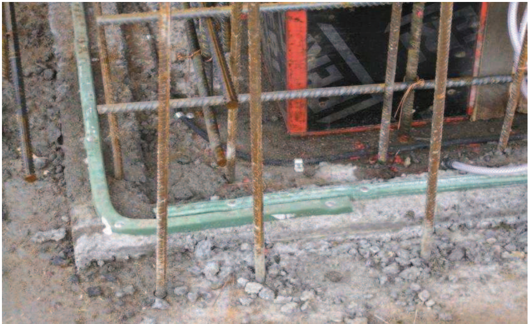
Figur 29. Bentonitband (grönabandet) och injektorslagen (svarta slangen) placerad vid arbetsfogen mellan grundplattan och bassängväggarna. /74/
