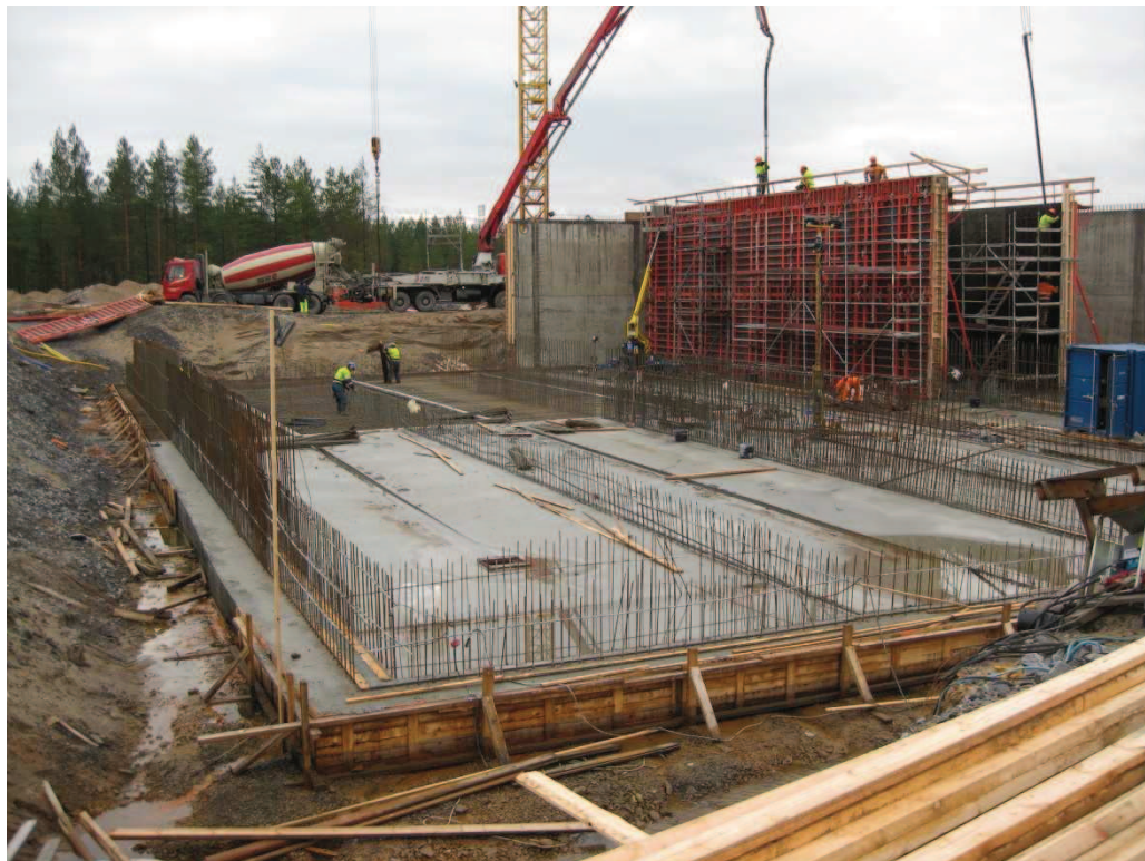
Figur 26. Armering av en markplatta och gjutning av en bassängvägg. /74/
