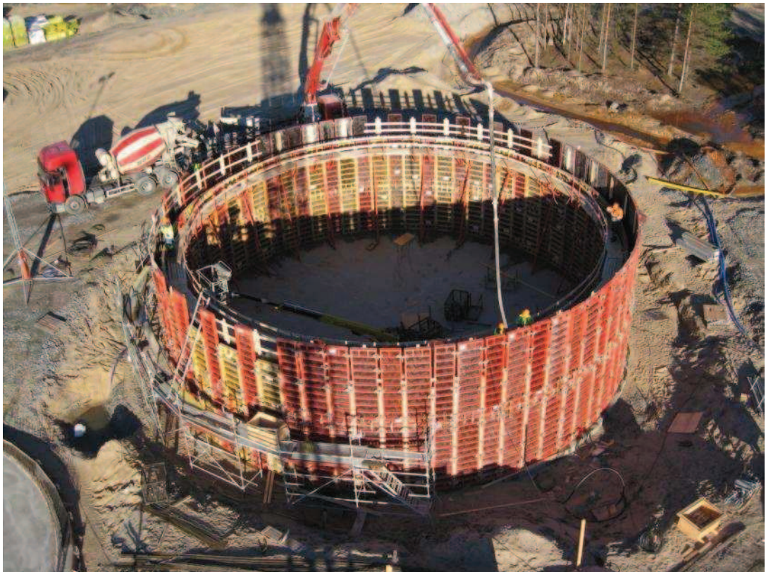
Bild 27. Väggar gjuts för en av bassängarna. /74/
