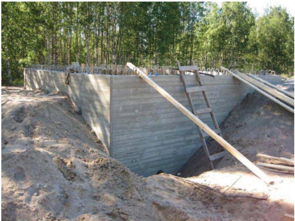
Figur 24. En brunn som är gjuten med vattentät betong. /74/
