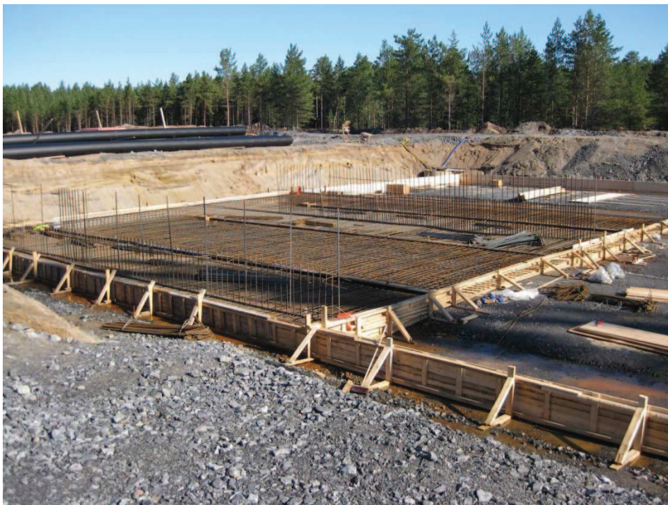
Figur 28. Armerad markplatta och en rörelsefog. /74/
