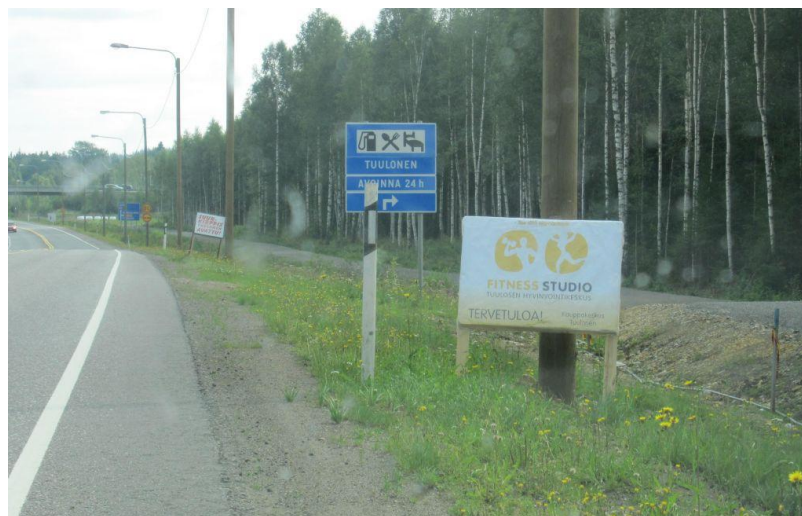
Kuva 8. Liian lähellä asetettu mainos ja liikennemerkki kilpailevat kuljettajan huomiosta.
