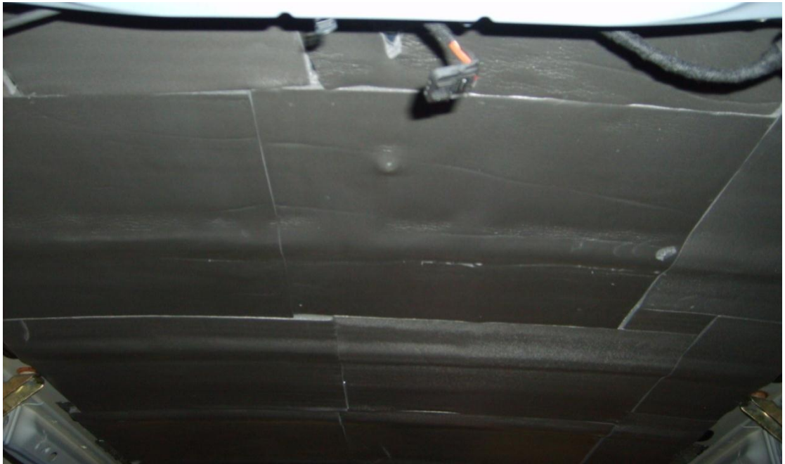
KUVA 14. Raskasmaton päälle asennettu solukumimatto
