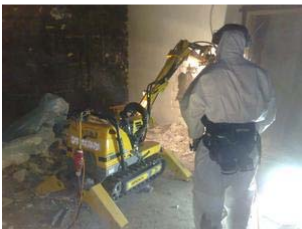
KUVA 5. Piikkausrobotti (Helsingin rakennus ja purku ky, 2011)
