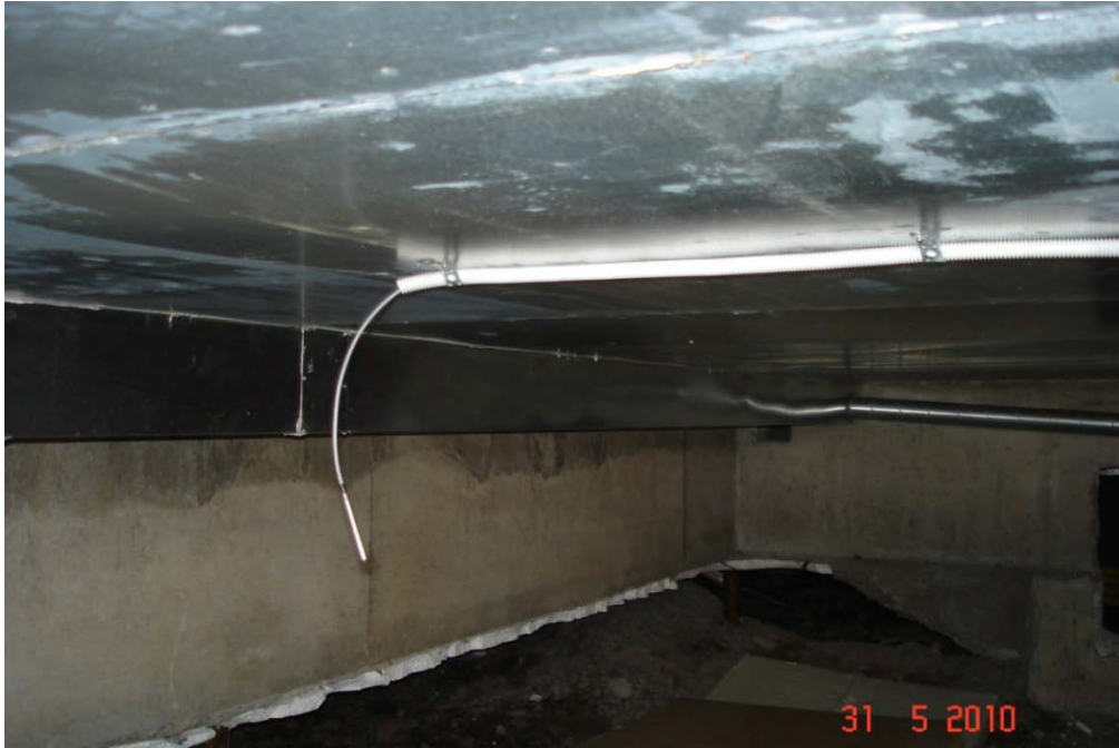
KUVA 13. Lämpötilan ja ilmankosteuden mittaus rossipohjassa
