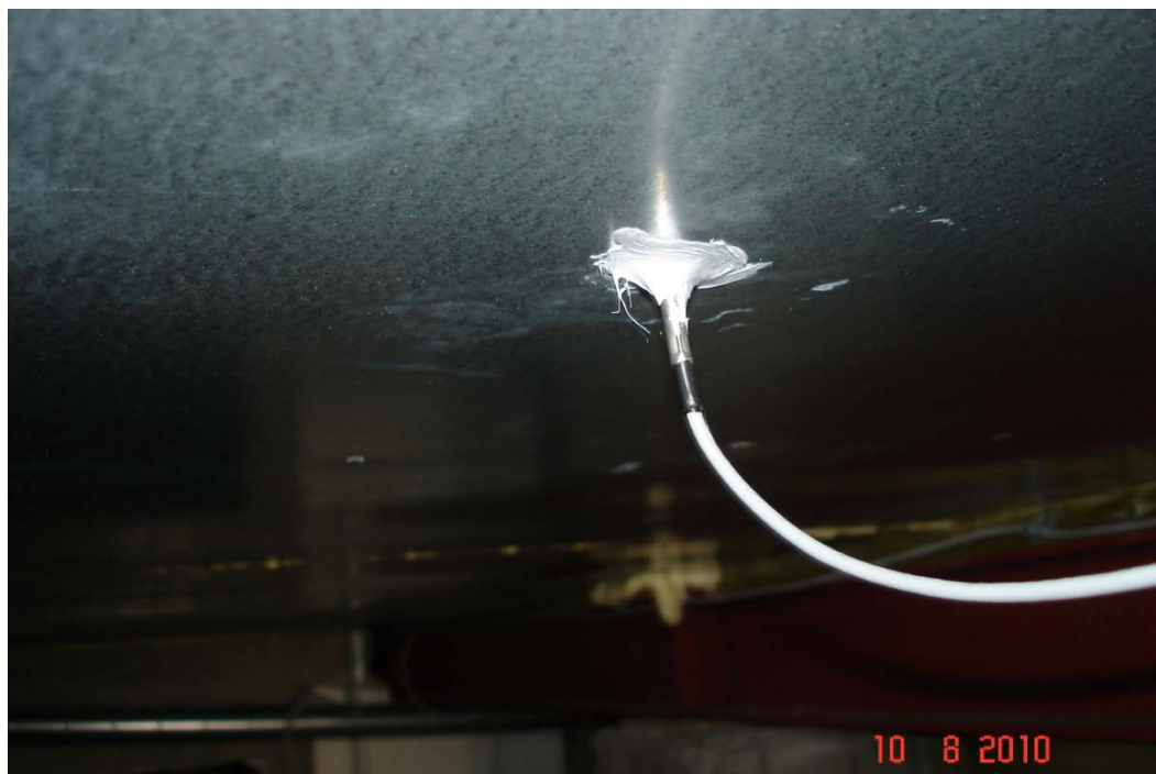
KUVA 15. Alapohjan eristeiden lämpötilan ja kosteuden mittaus
