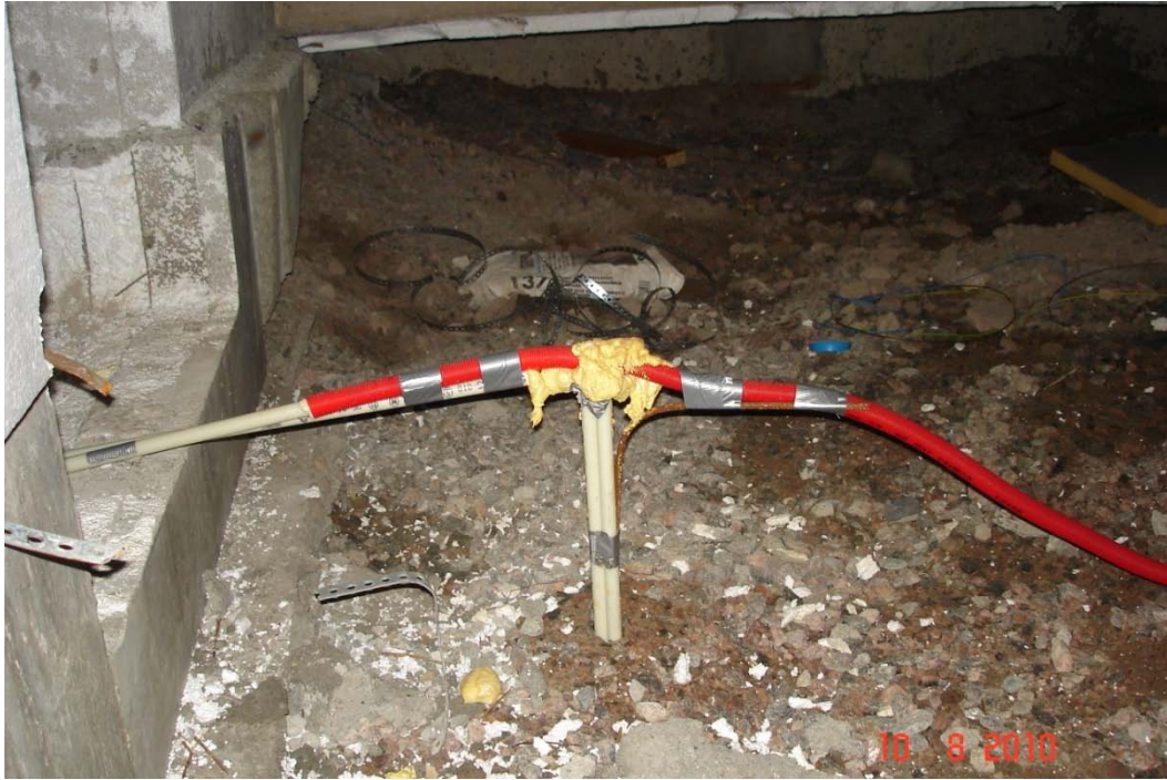
KUVA 16. Maalämpötilan mittaus rossipohjassa
