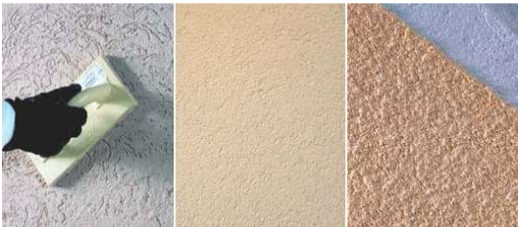
KUVA 5. Vasemmalta oikealle: piirtopinta, hierretty pinta ja hienoroiskepinta (Timo Rautanen 2006, muokattu).
