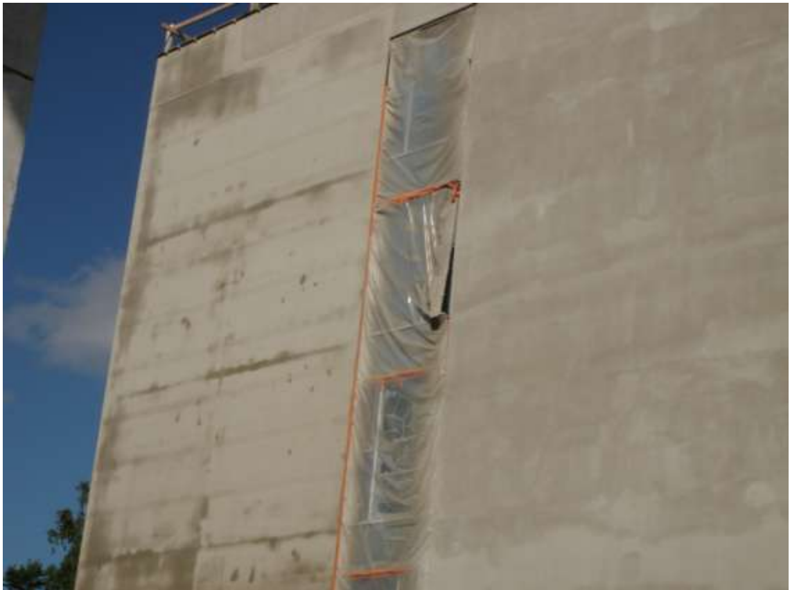
KUVA 16. Valmis verkotuslaastikerros.
