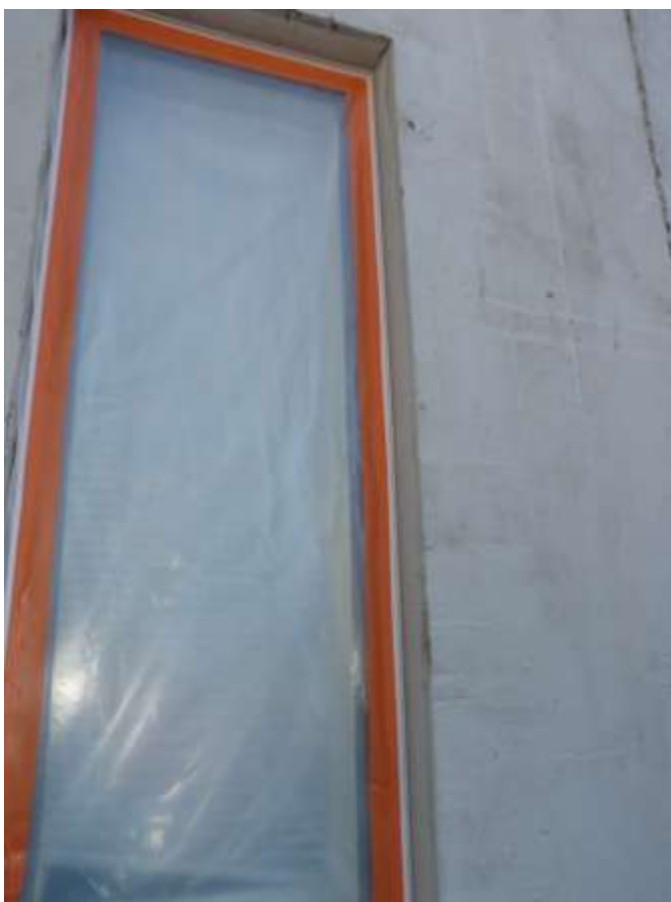
KUVA 15. Ikkunoiden suojaus ja ikkunaprofiilit.
