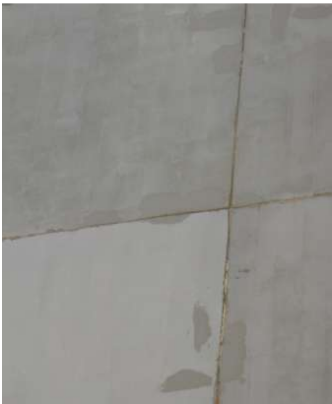
KUVA 14. Julkisivun laastipaikkauksia.
