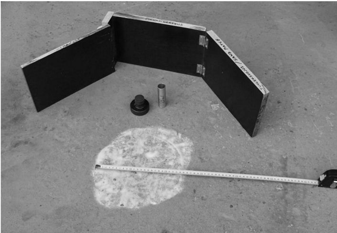
Kuva 1. Eristysalustan pinnan karkeuden mittausvälinesarja: Lasihelmet, mitta-astia, levitystyökalu, metrimitta, tuulensuojus. (Sillan vedeneristystyömaan laadunmittaus, 16 © Liikennevirasto 2009.)
