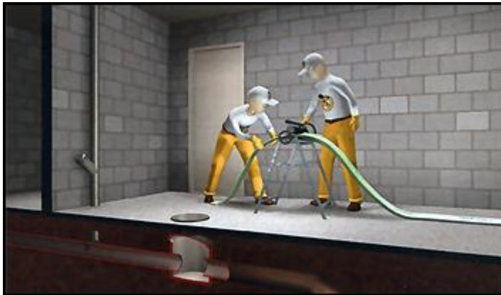
Kuva 23. Epoksiseos levitetään sukkaan mankelin avulla (Suomen Putkisto Palvelu Oy 2011).
