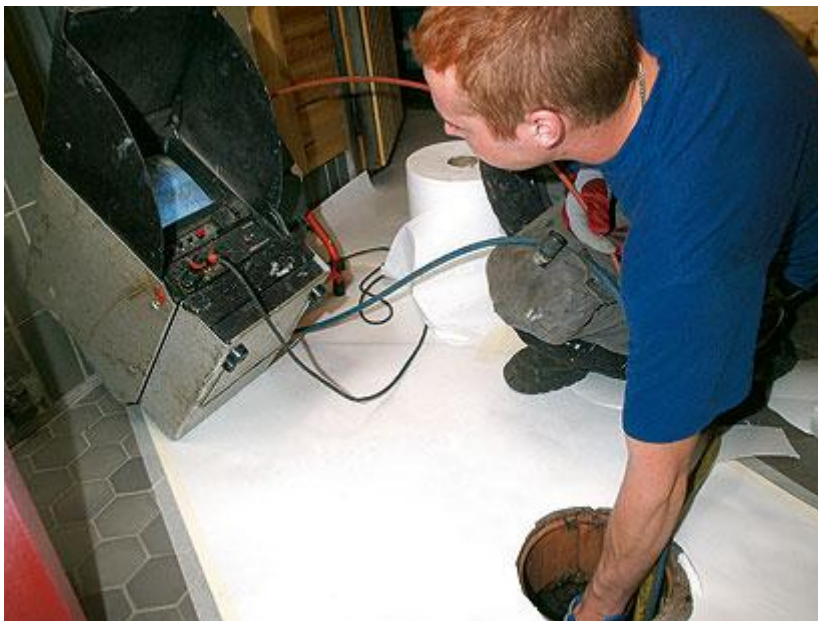
Kuva 3. Kameravalvonnalla varmistetaan, että pinnoitetta menee joka paikkaan (Hietala 2008).
