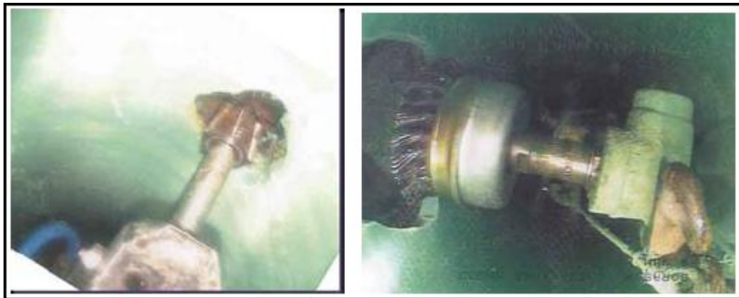
Kuva 13. Haaran avaus ropottiporalla (Nordic Renovation Group 2011).
