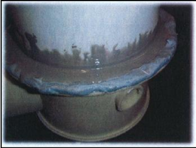
Kuva 28. Muovisen korokerenkaan liitos TKR-pinnoitteella muovikaivoon. Vastaavalla tavalla voidaan muovinen korokerengas liittää TKR-pinnoitettuun valurautakaivoon. (Raatikainen 2011.)
