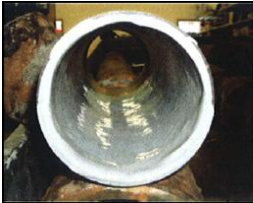
Kuva 25. TKR-putkimassalla käsiteltyä putkea (Raatikainen 2011).
