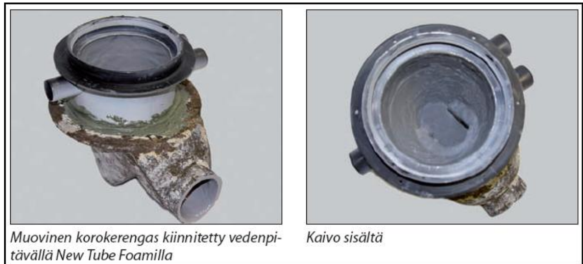
Kuva 21. Muovisen korokerenkaan liitos valurautakaivoon (RT-kortti 37925).
