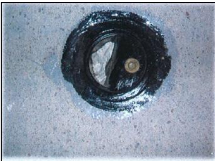
Kuva 30. Kahteen kertaan pinnoitettu lattiakaivo (Raatikainen 2011).
