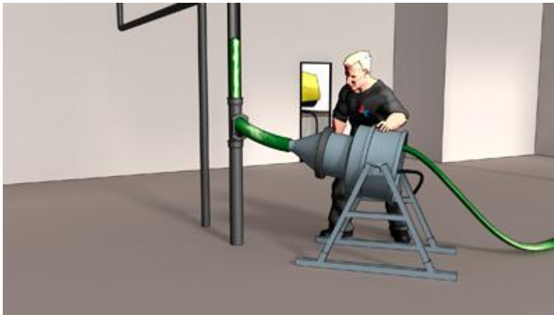
Kuva 5. Periaatekuva sukkasujutuksesta (Putkireformi 2011).
