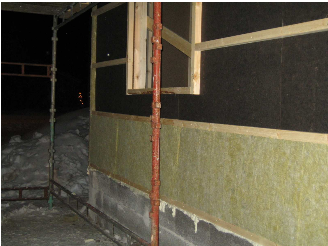
KUVIO 2. Sudenmarja 6:n ulkoseinä rakennusvaiheessa.
