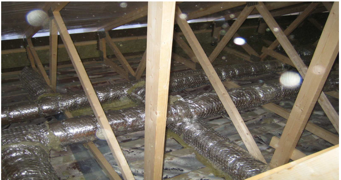
KUVIO 3. Sudenmarja 6 ilmanvaihtoputkien eristys yläpohjassa.
