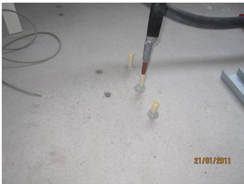
Kuva 5. Reikien imurointi holkin läpi.
