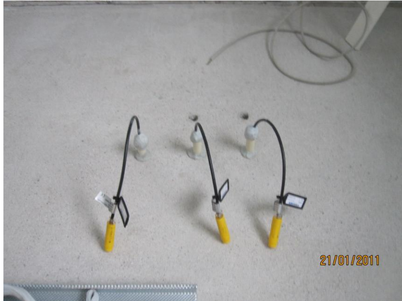
Kuva 6. Mitta-antureiden asennus holkkeihin ja holkin tiivistys.
