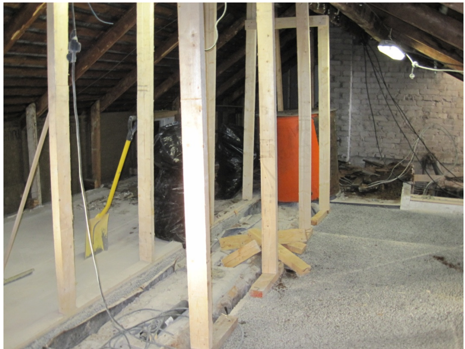
Kuva 6 Ullakkotilan vesikaton tuennat
