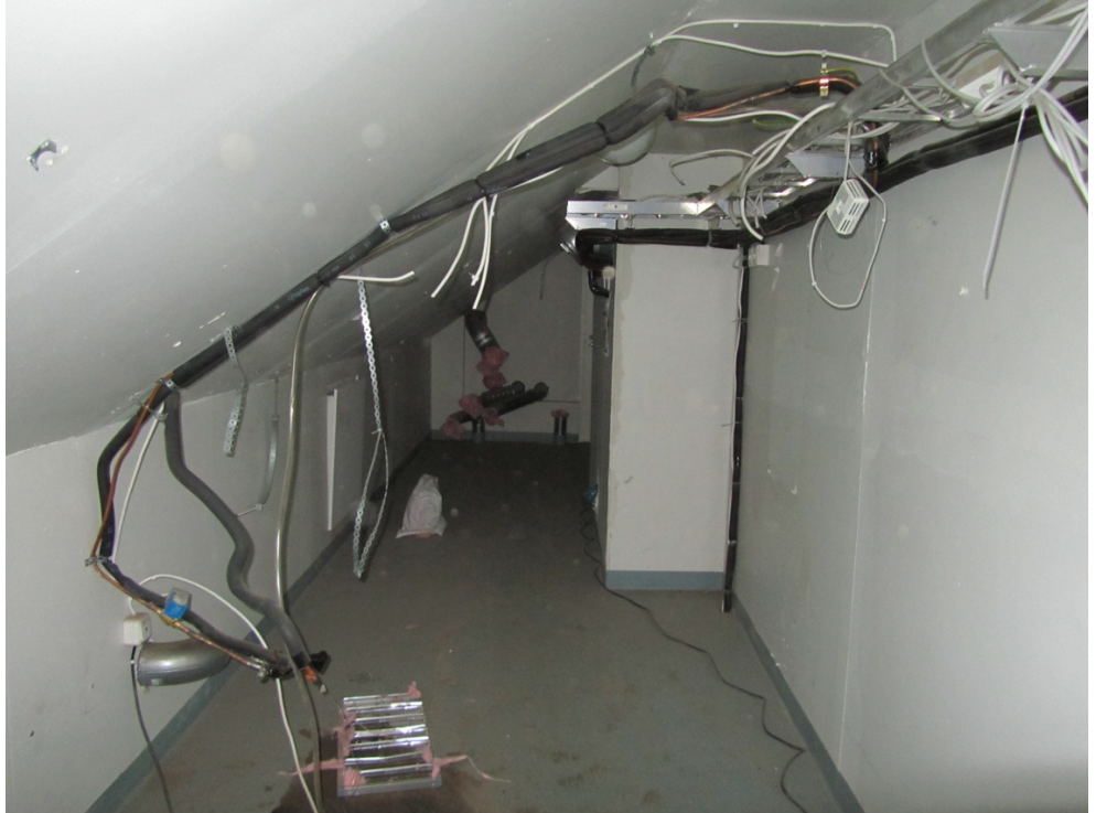
Kuva 4 Ullakkotilan lämmin puoli
