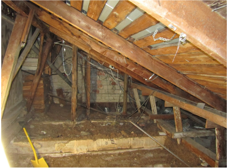
Kuva 5 Ullakkotilan kylmä puoli
