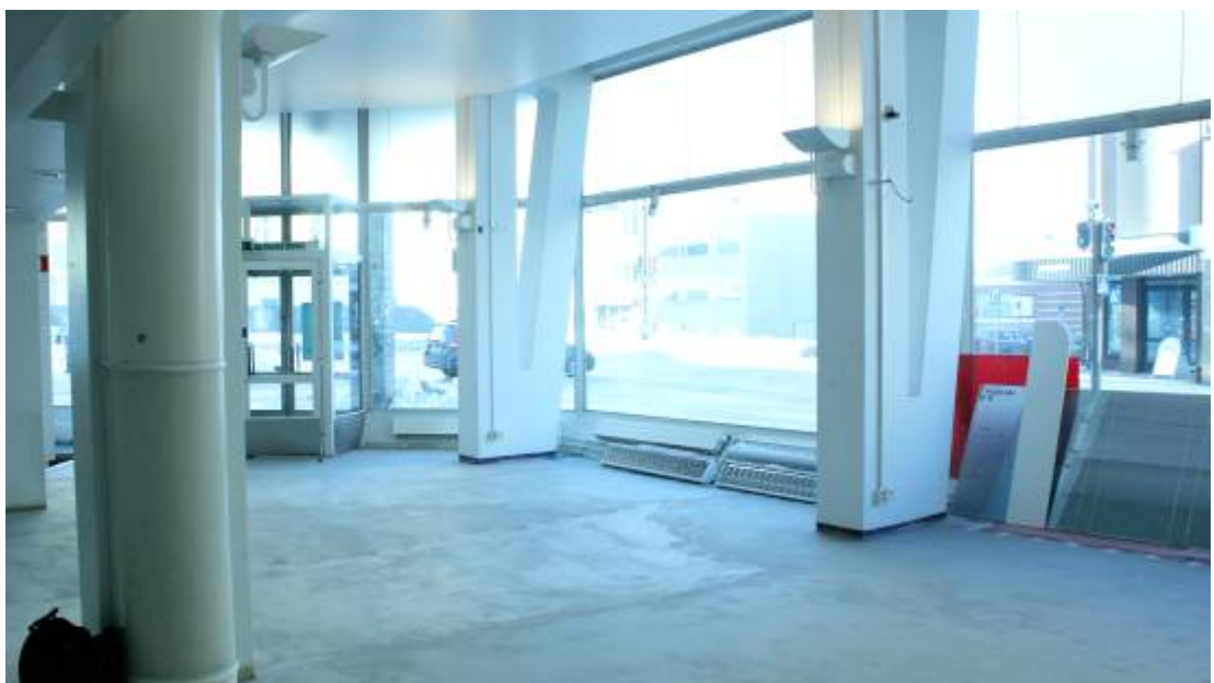
Kuva 3. Ikkunat ja pilarit
