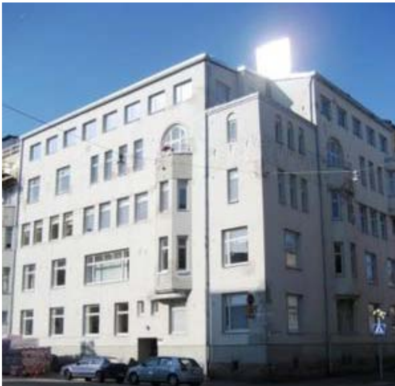
KUVA 1. Julkisivukuva rakennuksesta ennen restaurointia
