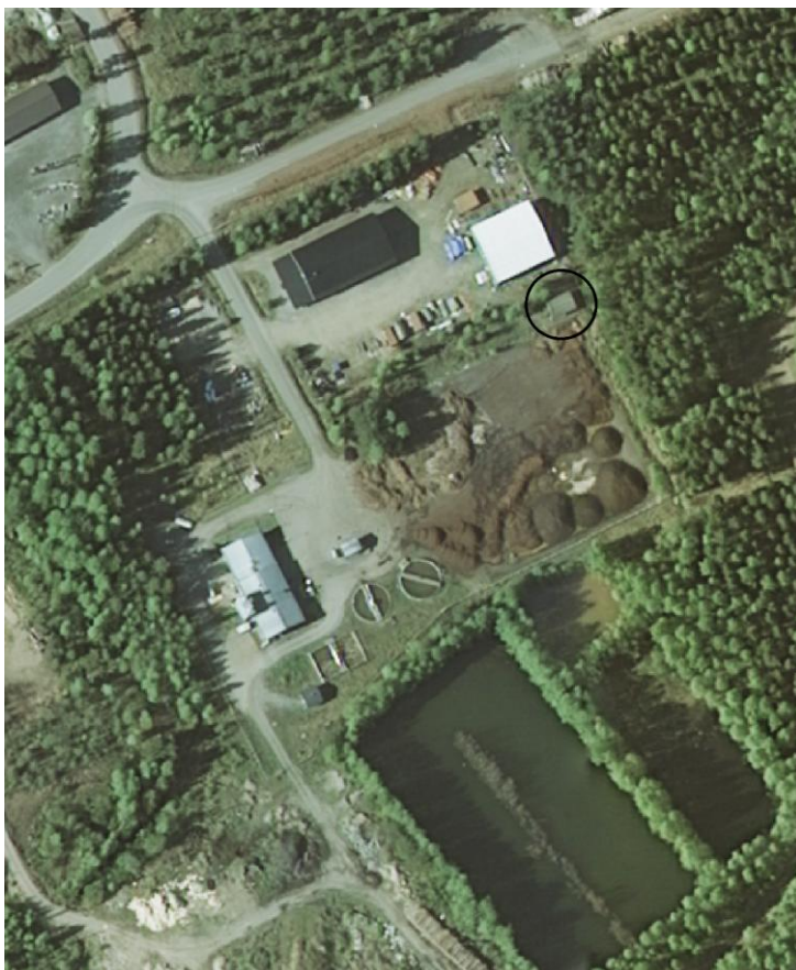
Kuva 1. Paineenkorotuspumppaamon sijainti jätevedenpuhdistamon tontilla (Lähde: Viitasaaren kaupunki)
