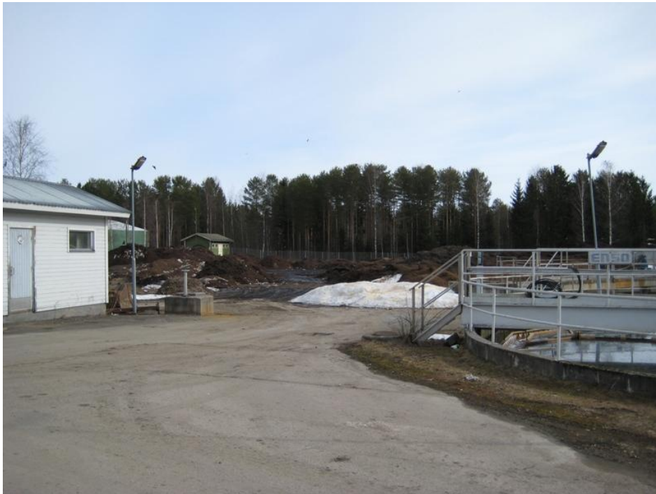
Kuva 3. Näkymä jätevedenpuhdistamon pihalta pumppaamolle
