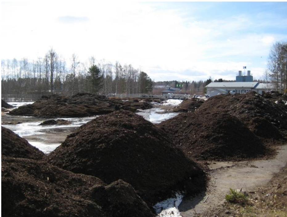
Kuva 4. Näkymä pumppaamon edestä jätevedenpuhdistamolle
