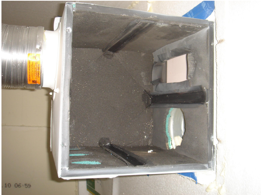
Kuva 18. LTO-laite sisältä.
