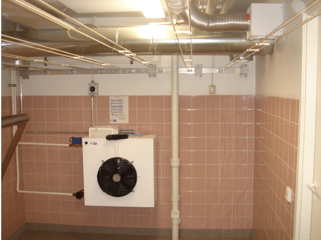
Kuva 5. Koivikkotie 5:n kuivaushuone.
