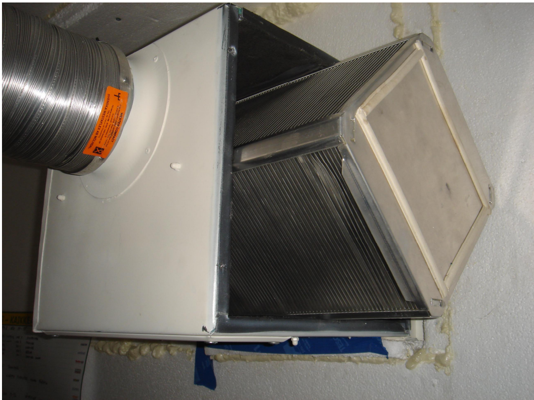
Kuva 17. LTO-kennon irrotus laitteesta.
