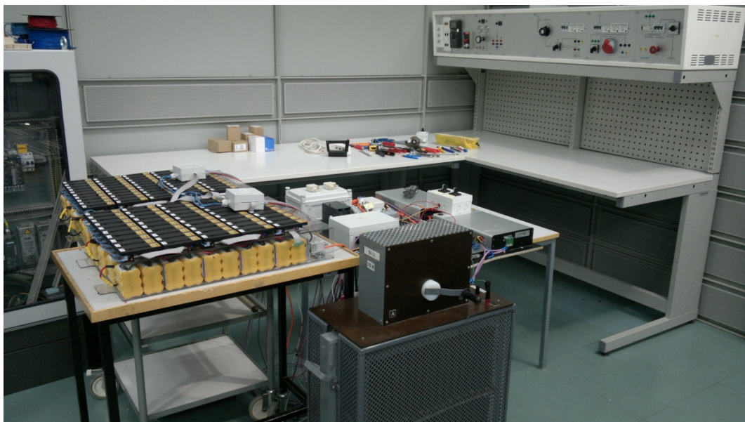
Kuva 12. Sähkömopoauton akuston latauksen testaus.
