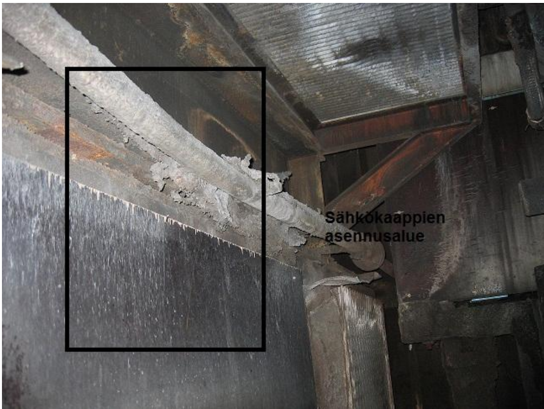
Kuva 10. Jäädytysvyöhykkeiden 1-4 asennettavien pyrometrieni sähkökaappien asennuspaikka. /5/
