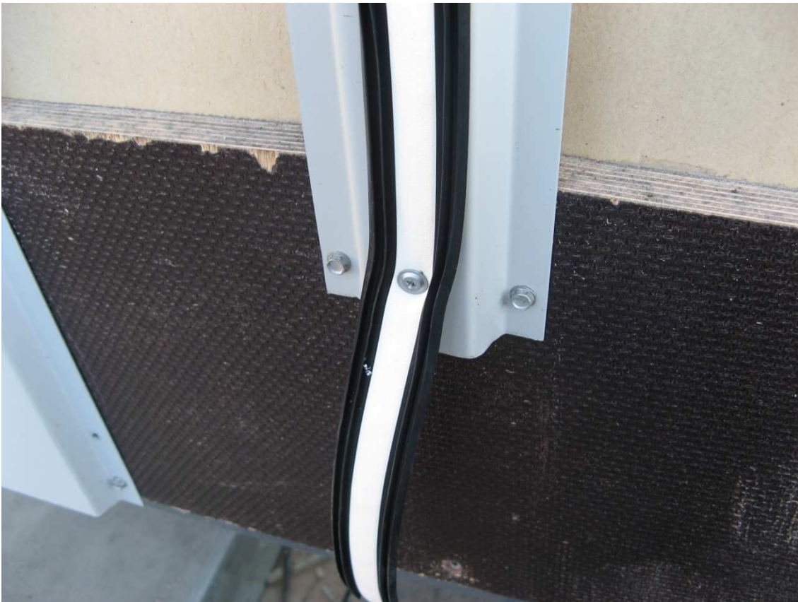
Kuva 10. EPDM-nauhan kiinnitys ruuvilla on nopeampaa kuin sen liimaaminen.
