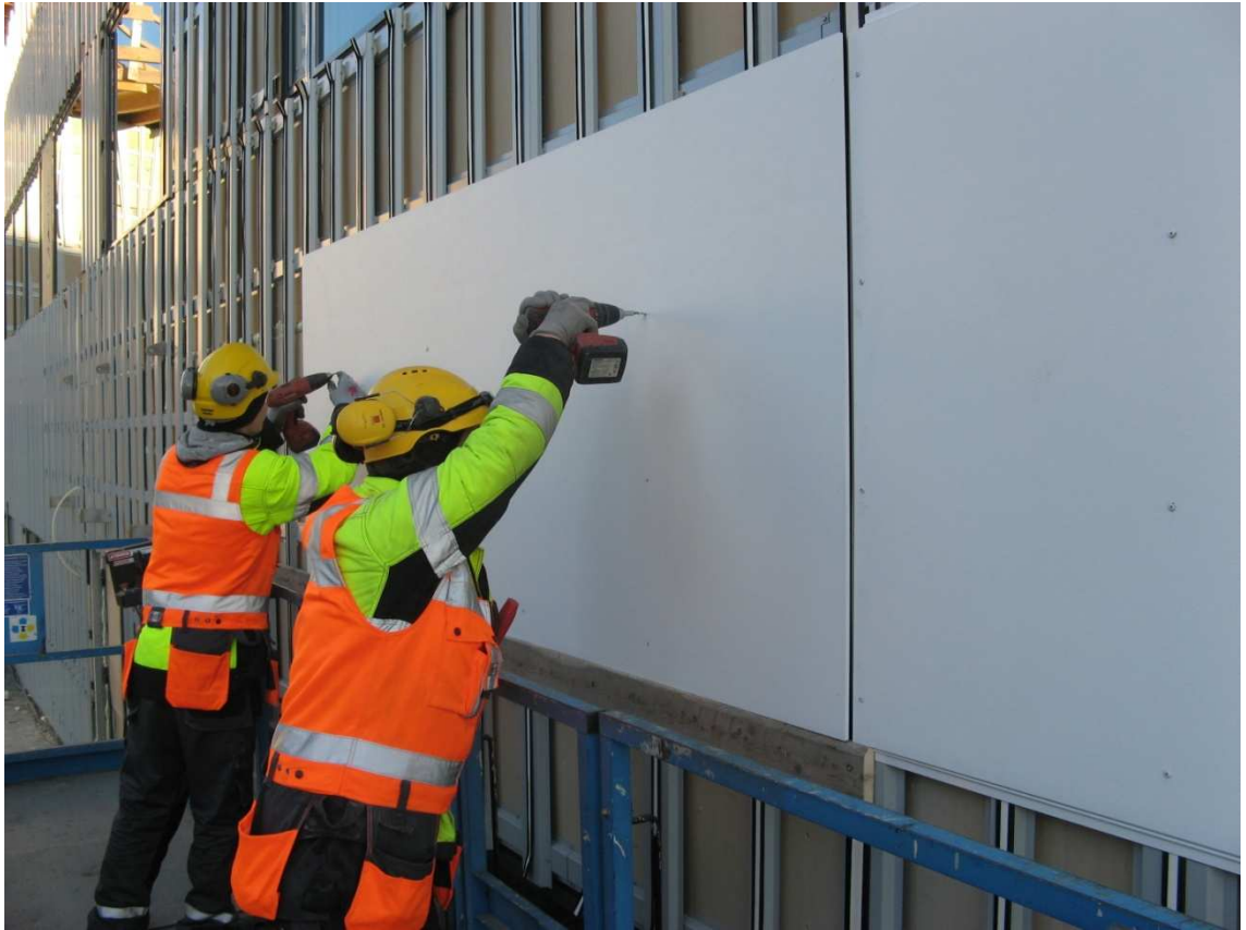
Kuva 15. Ensimmäiset levyt saadaan oikeaan korkoon asennustukena käytettävän laudan avulla. Kuva Iiro Mutanen 2010.
