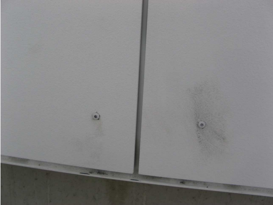
Kuva 6. Ruuvia kiinnitettäessä muodostunut pöly on tarttunut kosteaan levyn pintaan. Kuva Iiro Mutanen 2010.
