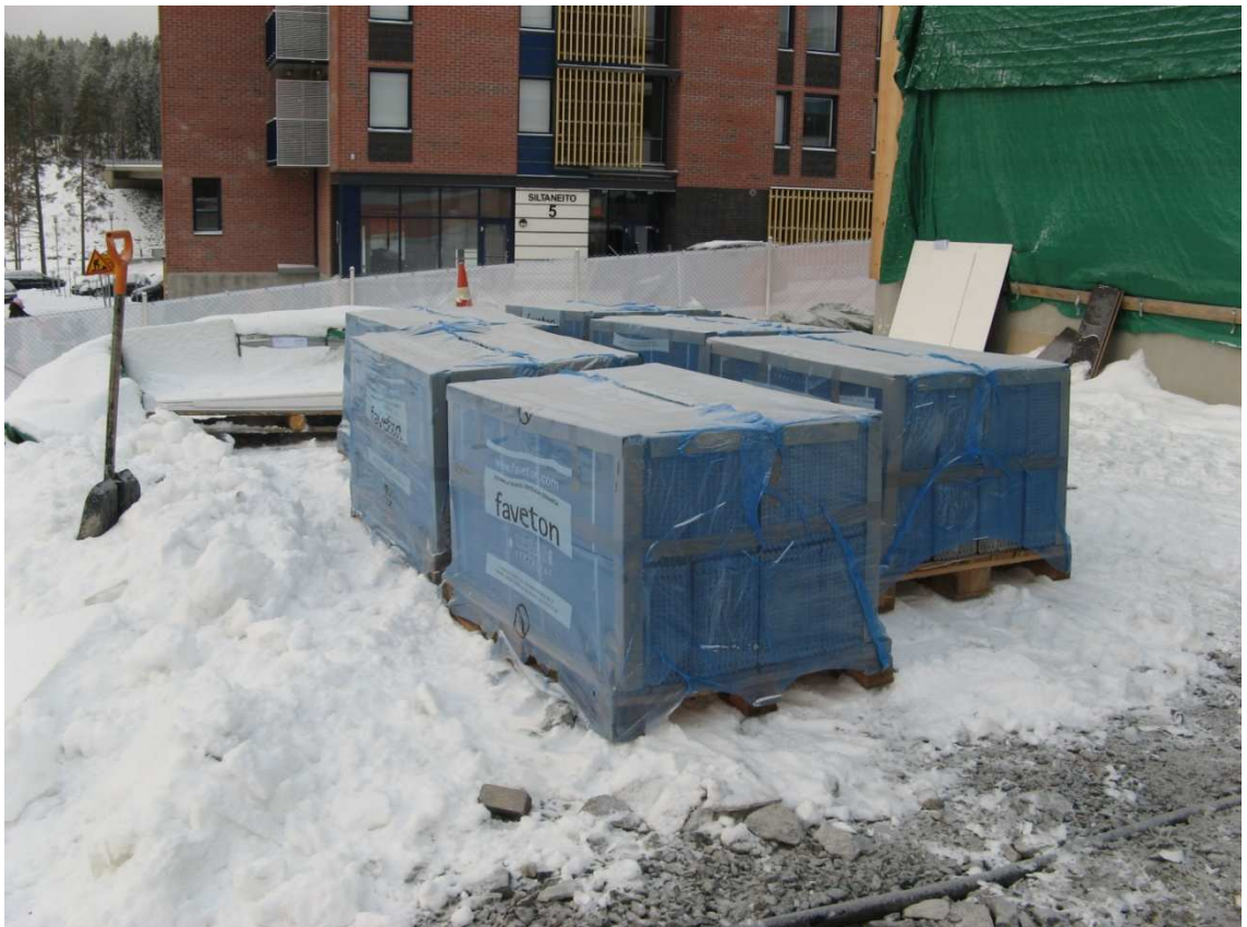
Kuva 13. Tavarat purettiin asennuskohteen viereen, käsinkantomatkan päähän. Kuva Iiro Mutanen 2010
