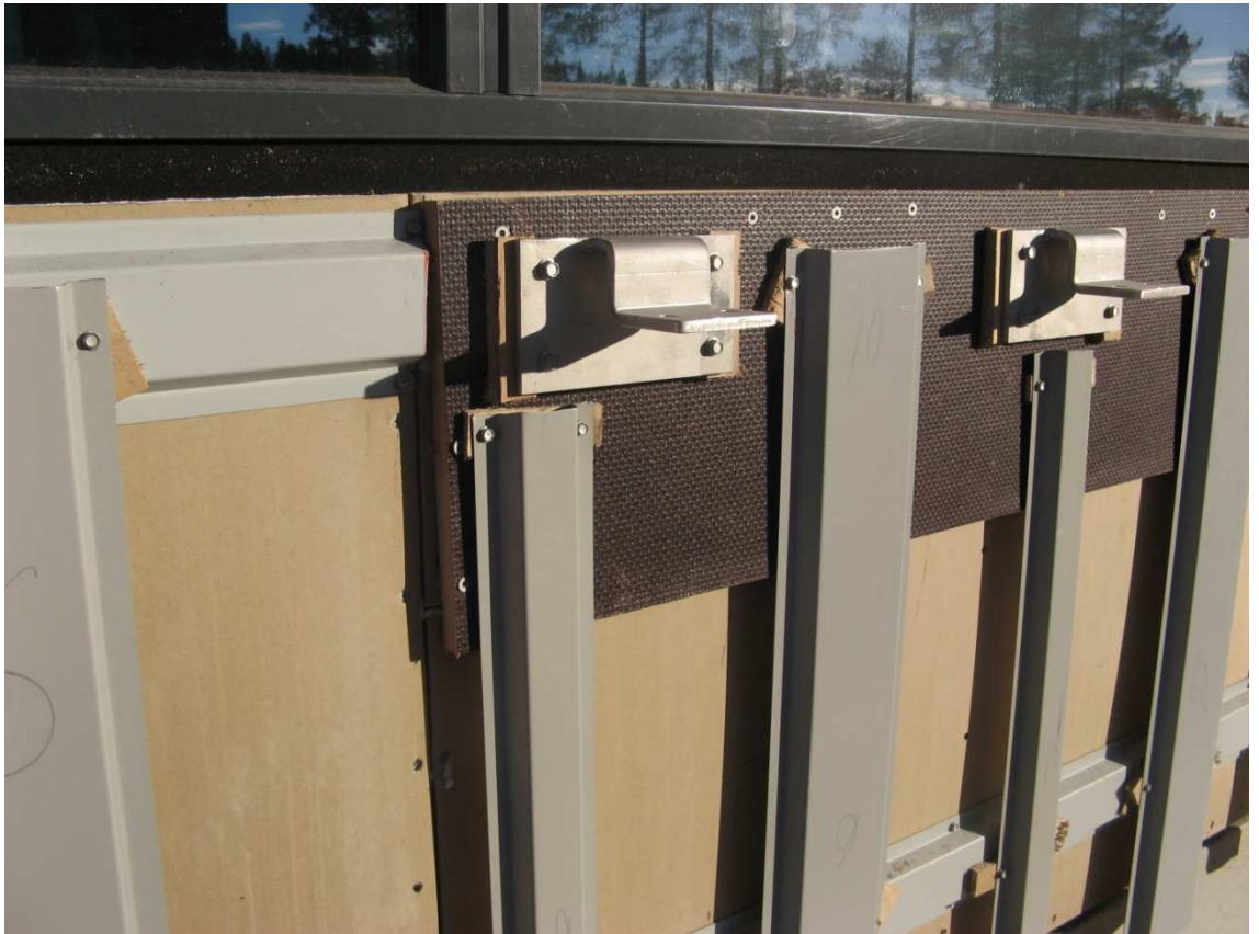
Kuva 13. Julkisivuun kuuluvien väri lasien ja puuritiikköjen ruostumattomasta teräksestä tehdyt kiinnikkeet vanerisine vahvikepohjineen. Kuva Iiro Mutanen 2010.
