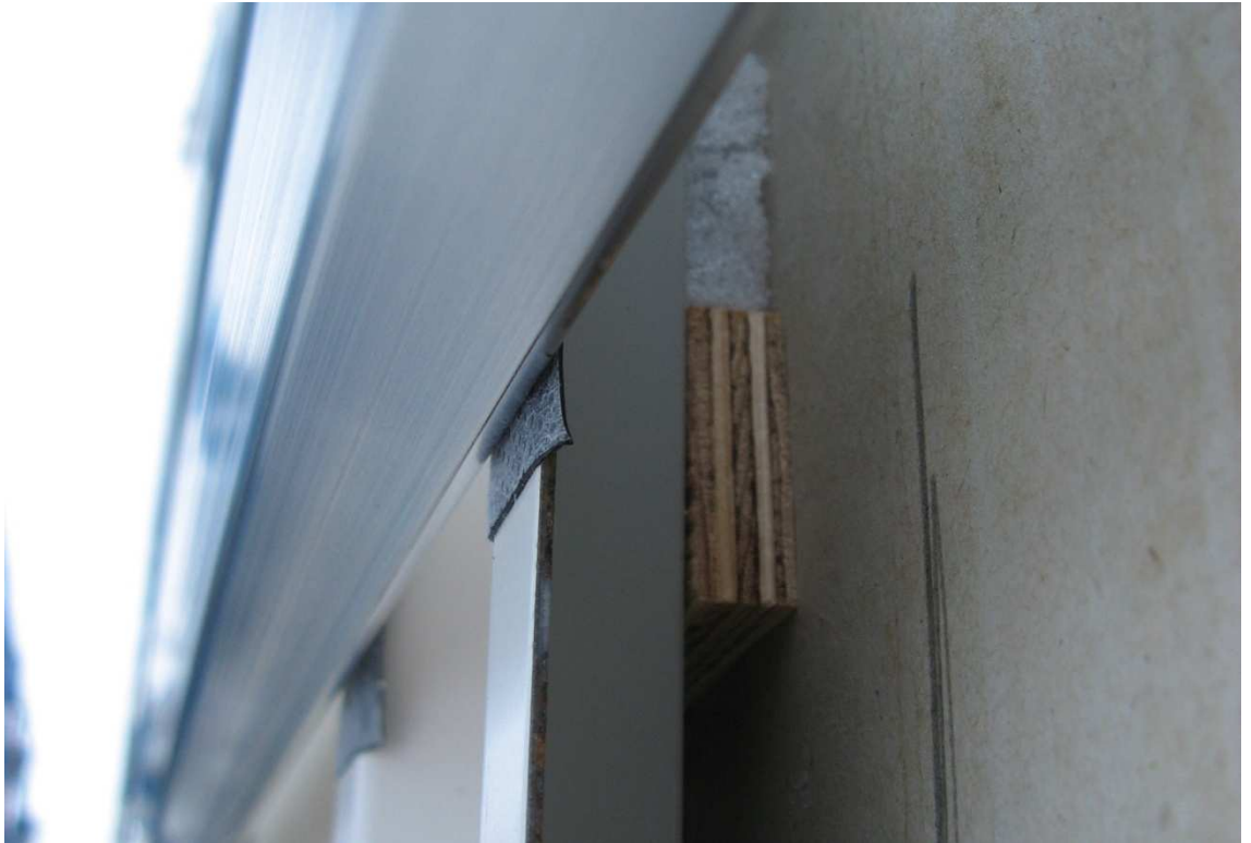
Kuva 2. Teräksisen pystykoolauksen ja alumiinisen vaakakoolauksen väliin pannaan kumiset laput korroosion estämiseksi. Kuva Iiro Mutanen 2010.
