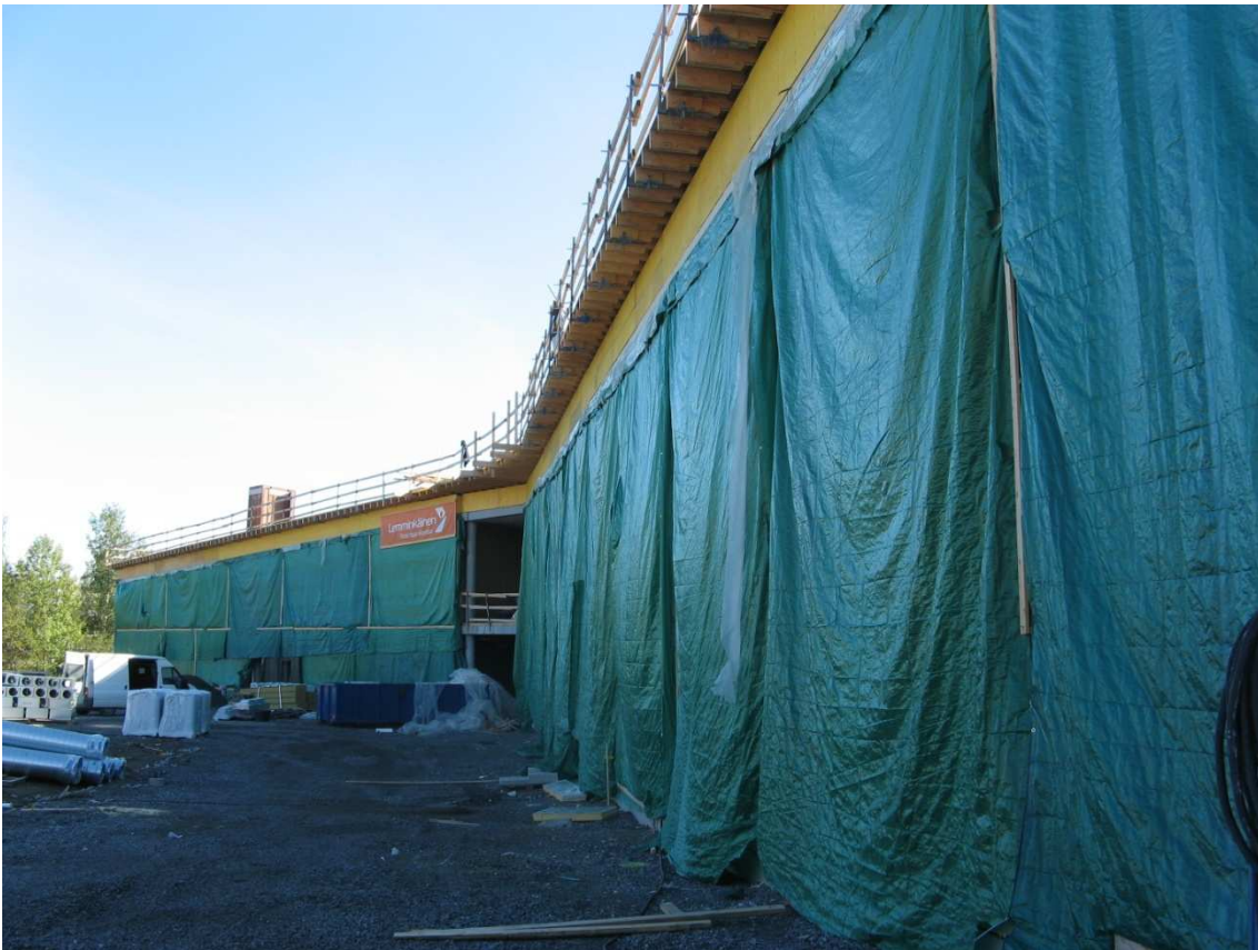
Kuva 4. Sateelle arka tuulensuojalevy on suojattu kevytpeitteillä. Kuva Iiro Mutanen 2010.
