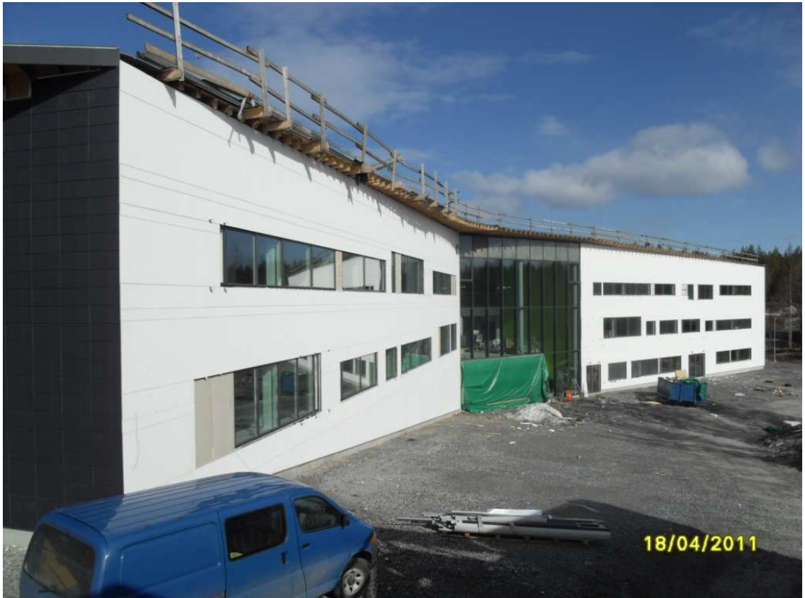
Kuva 1. Kohteen julkisivuverhoilussa käytetään kuitusementtilevyä, tiililaattaa ja lasia. Kuva Iiro Mutanen 2011.
