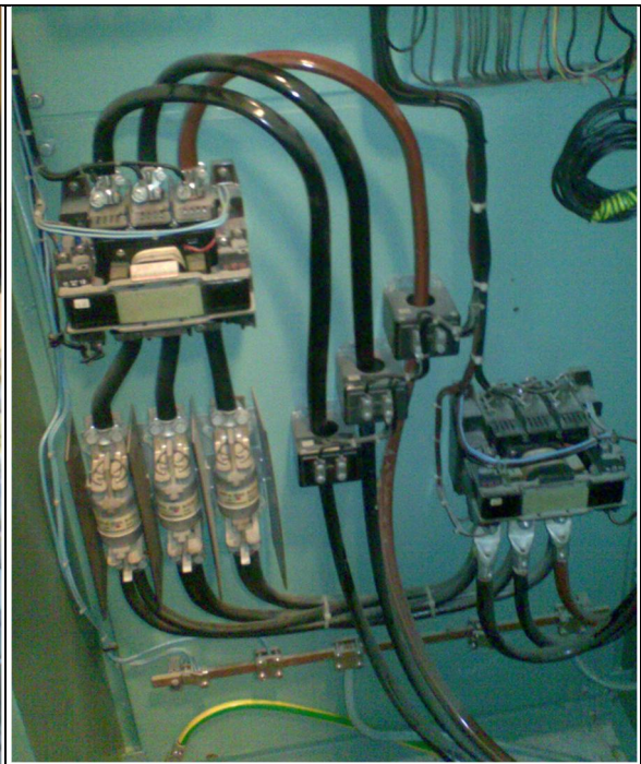
Kuva 8. Varavoimalaitoksen ohjauskaappi
