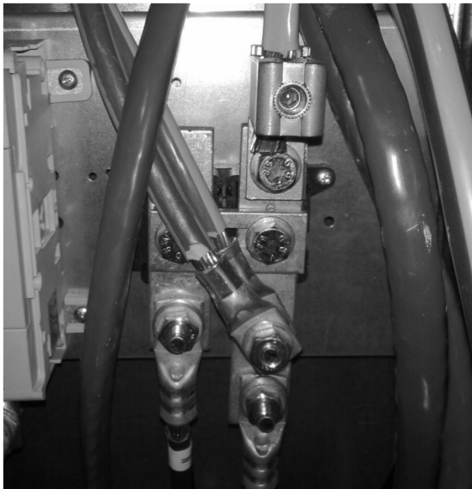
Kuva 5. N:n ja PE:n yhdistys, joka voidaan tarvittaessa avata.
