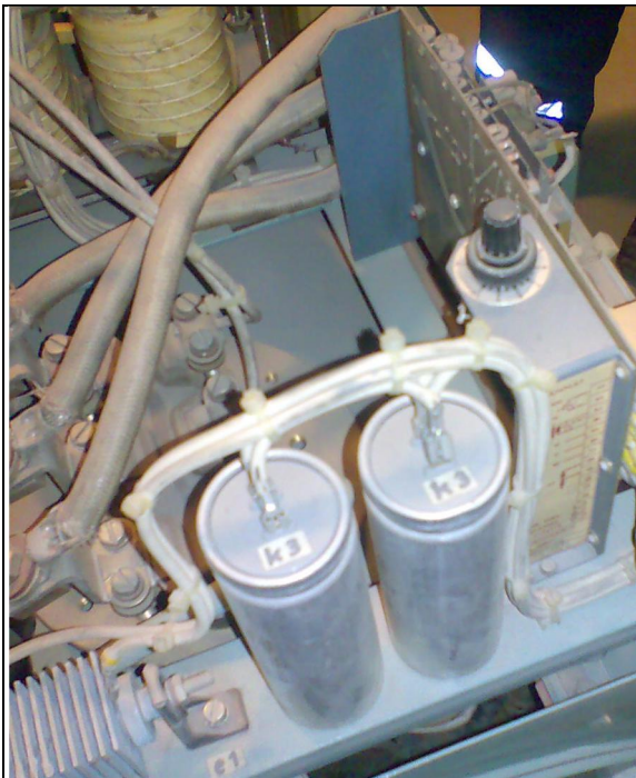
Kuva 7. Generaattorin jännitteensäätö
