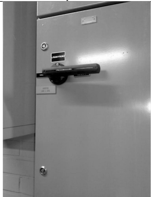
Kuva 4. Syöttö UPSilta.
