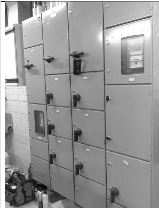
Kuva 3. Varavoimapäätöskeskus VVPK
