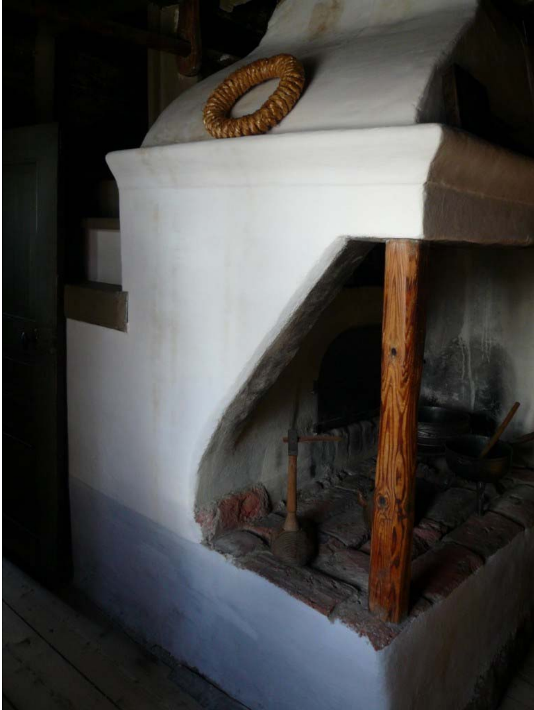
Kuva 8. Uuni 10.3.2011 Maali on pysynyt hyvin talvenkin yli muurissa.
