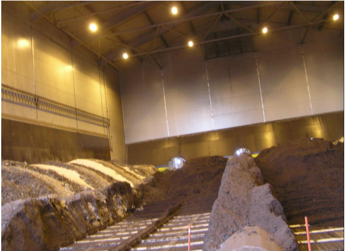
Biopolttoaineiden kuljetuslinja kuvattuna lastausovelta
