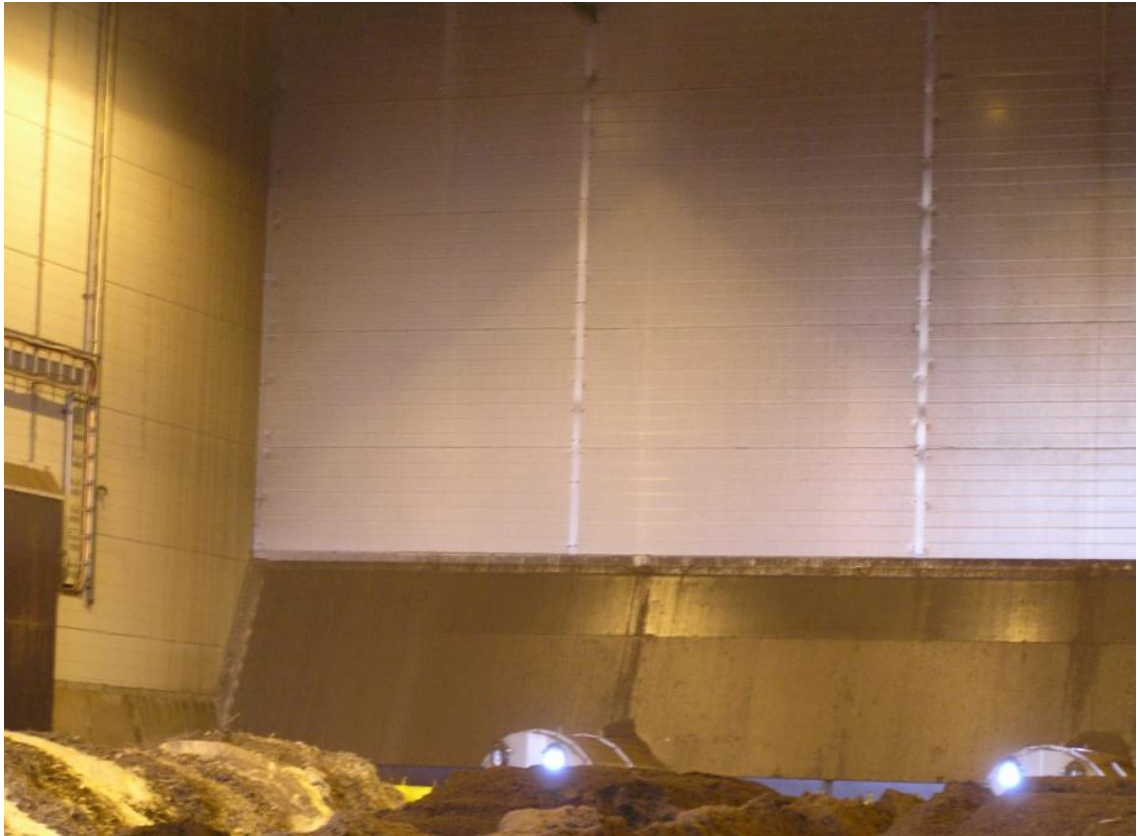
Hallin takaseinä kuvattuna lastausovelta
