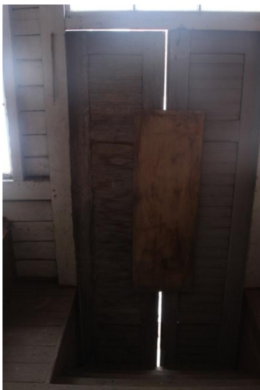
Kuva 11. Vanhan konttorin eteläpuolen väljä ulko-ovi.
