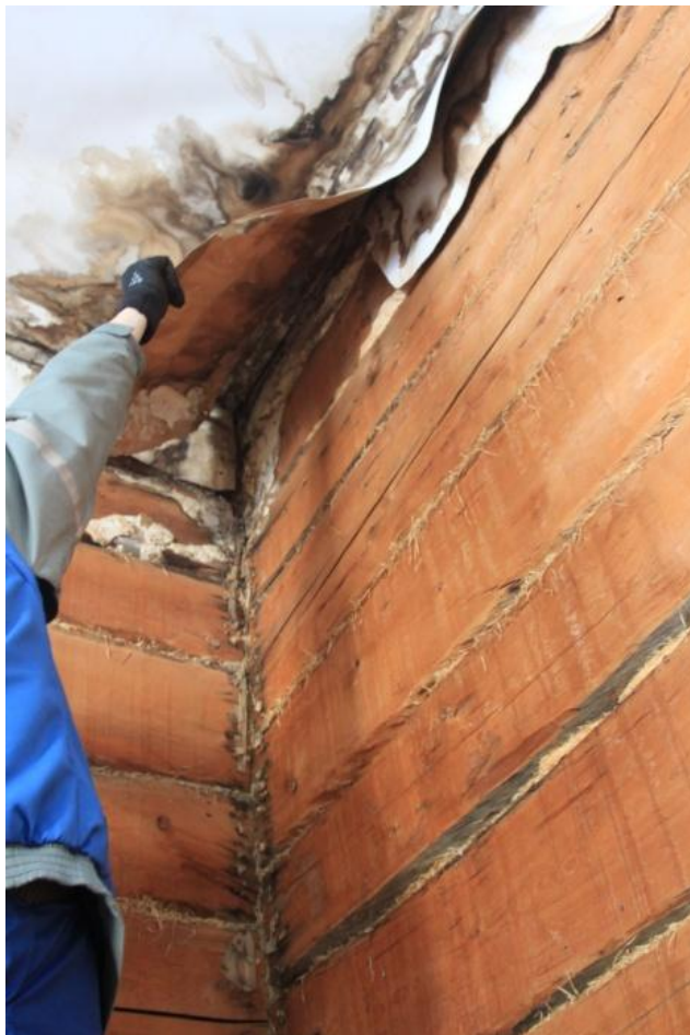
Kuva 9. Sama seinä pienen konttorihuoneen puolelta kuvattuna.
