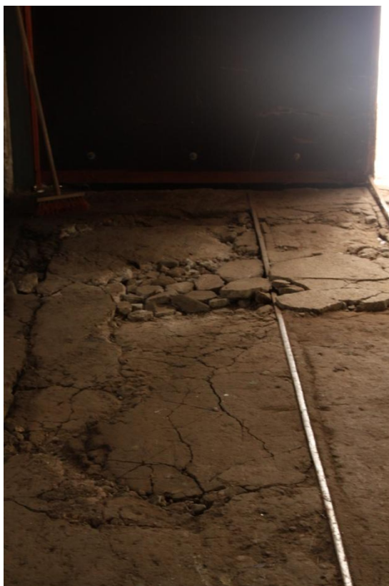
Kuva 23. Halkeamia keskilattiassa.
