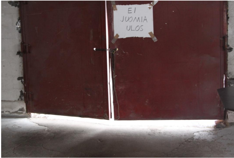
Kuva 20. Pulpperihallin väljä ulko-ovi.
