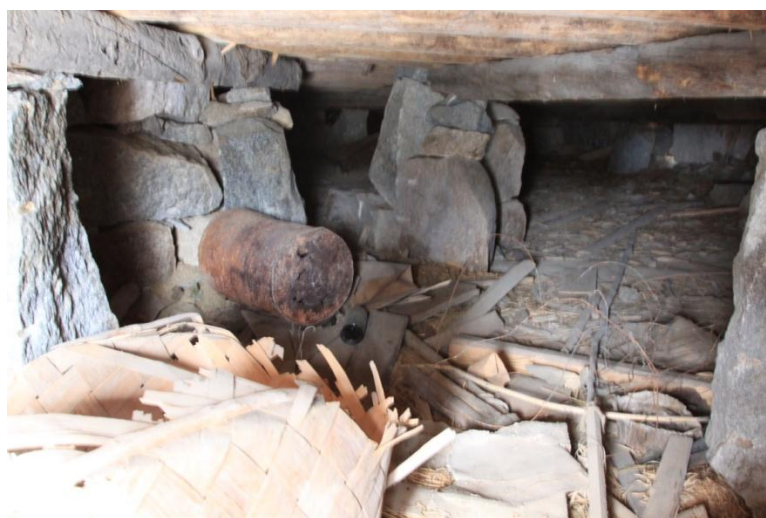
Kuva 7. Konttorin kantava alapohja.
