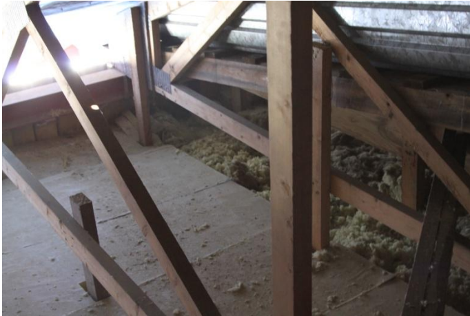
Kuva 15. Kartonkisalun yläpohjan eristyserot.
