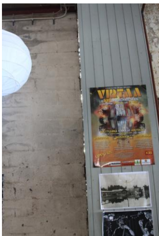
Kuva 21. Kartonkitehtaan ja pulpperihallin julkisivujen välinen rako.
