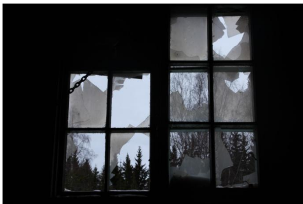
Kuva 24. Korjauspajan rikottu ulkoikkuna.
