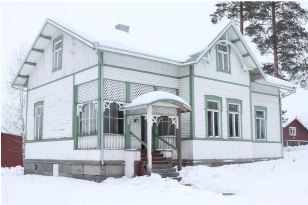
Kuva 1. Vanha konttori pohjoissivulta kuvattuna.
