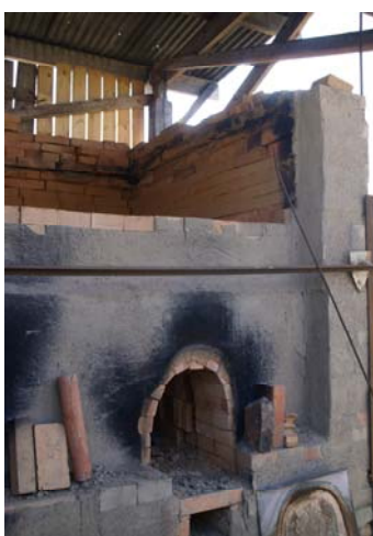
Kuva 30. Kultelan tiilitehtaan kenttäuunin kulma ja holvattu tulipesä Somerolla
