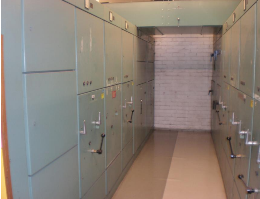
Kuva 15. Vanhoja pääkeskuksia muuntoasemalta 3
