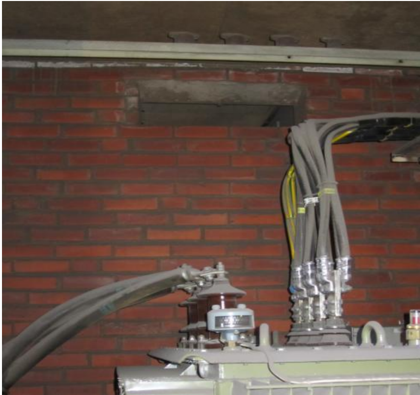
Kuva 10. Muuntajan TeM 31 tila, jossa puutteita. Reikä seinässä, josta pääsee likaa muuntoasemalle 2
