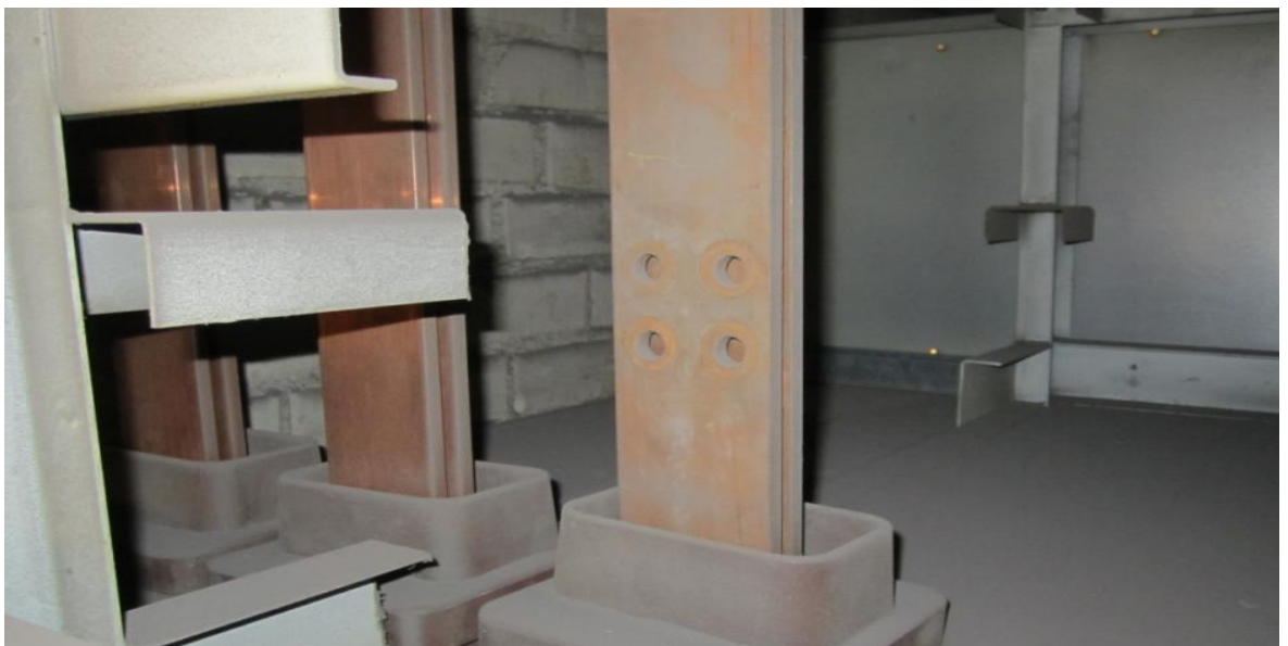
Kuva 11. Seinässä olevan reiän kautta tullutta pölyä ja likaa muuntoasema 2:n 400V kiskostossa
