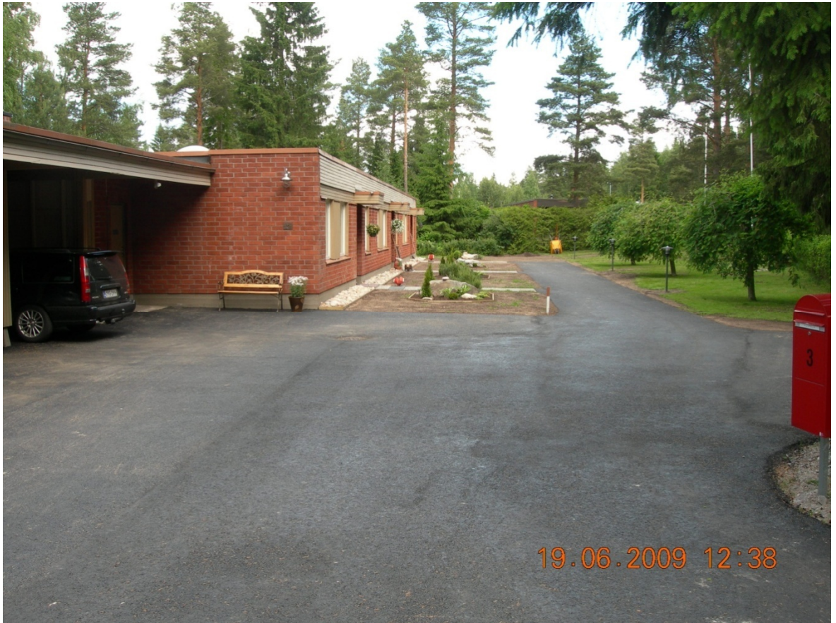
Kuvio 6. Piha-alue valmiina ja asfaltoituna.
