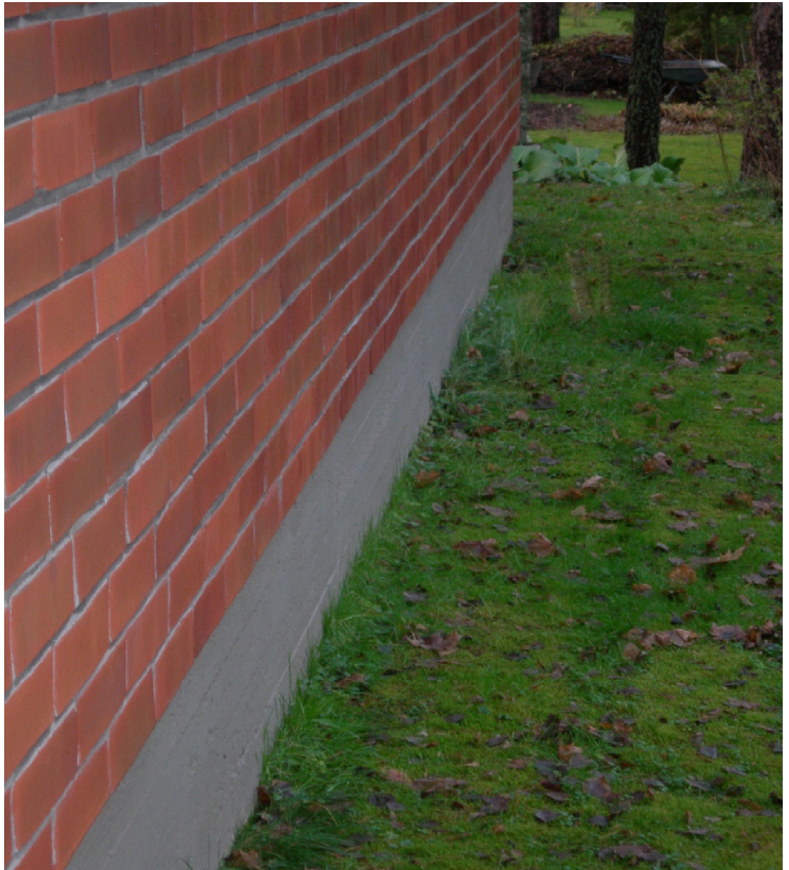
Kuvio 2. Pohjoispuolen päätyseinä.
