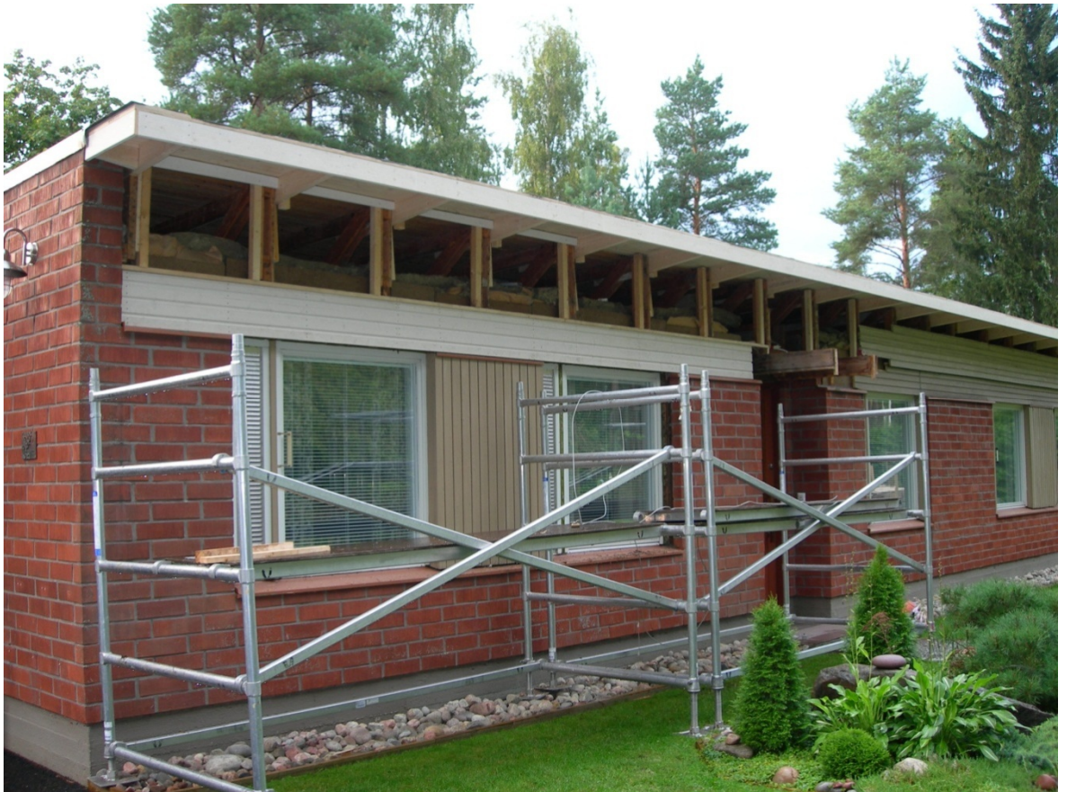
Kuvio 7. Rästäs- ja julkisivutyö.
