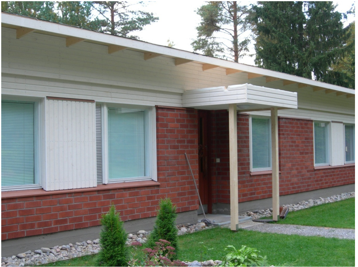
Kuvio 8. Muutostyöt valmiina.
