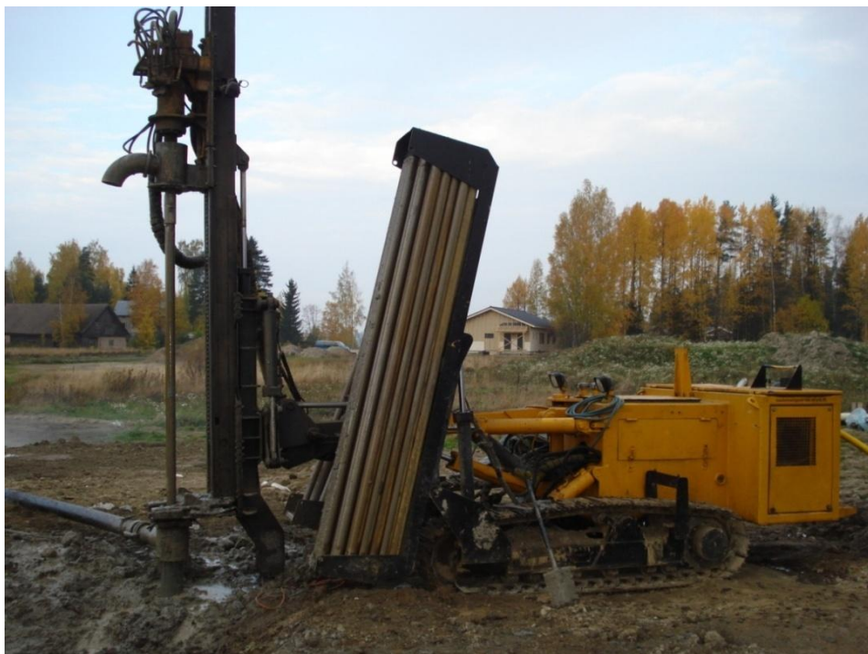
Kuva 11 Poravaunu ja poraustangot.
