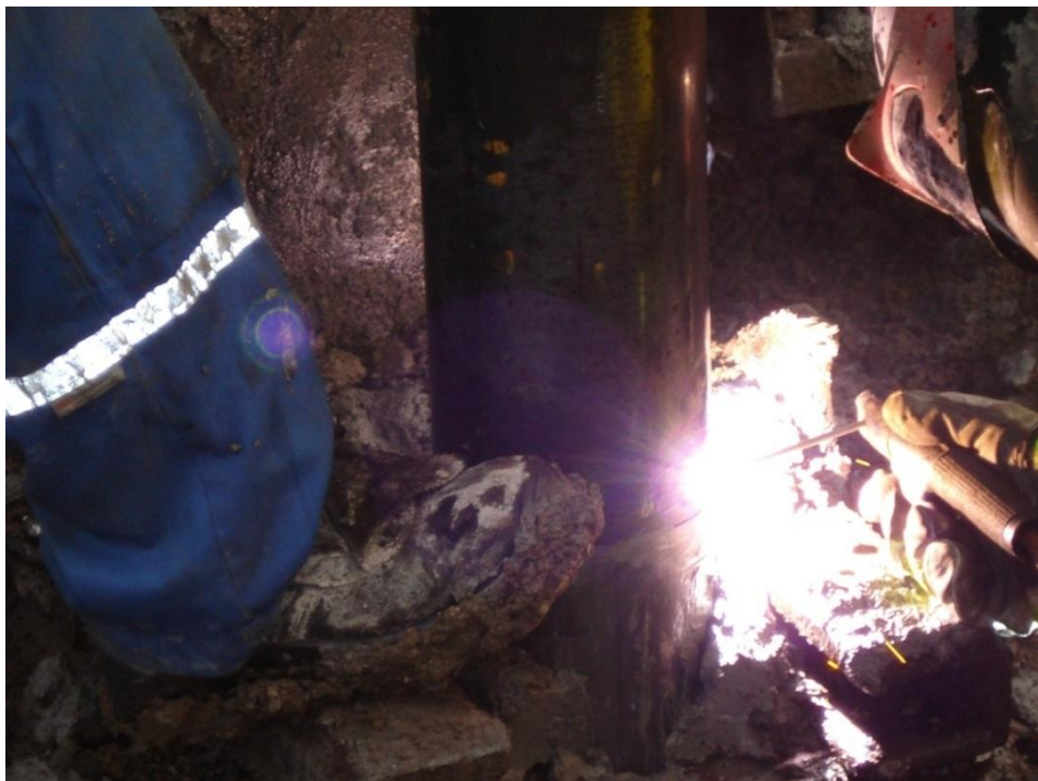
Kuva 8 Suojaputket hitsataan yhteen
