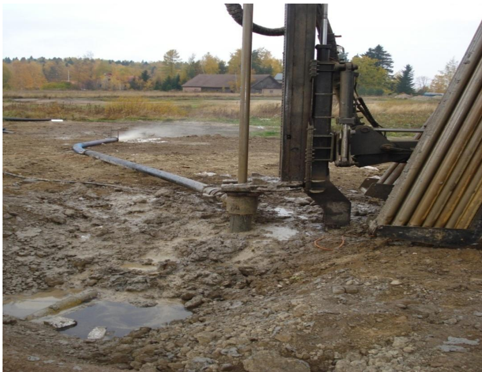
Kuva 12 Pintavesipainauma, johon porauslaitteesta valuvat öljy ja vaseliini kerääntyivät.
