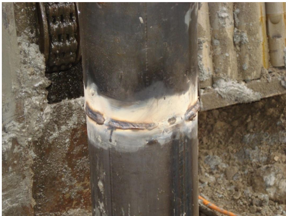
Kuva 9 Valmis hitsausseama
