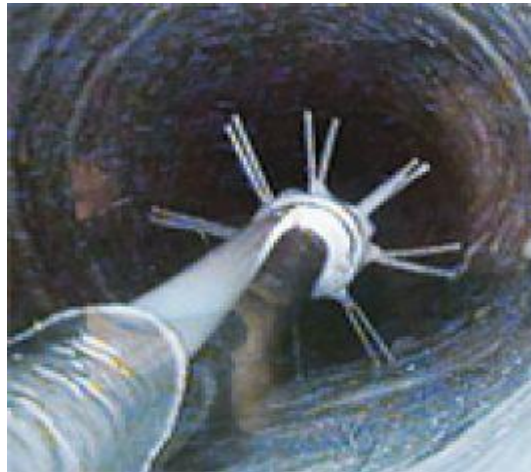
Kuva 1. Kuvassa viemäriputkea pinnoitetaan epoksimenetelmällä [6].
