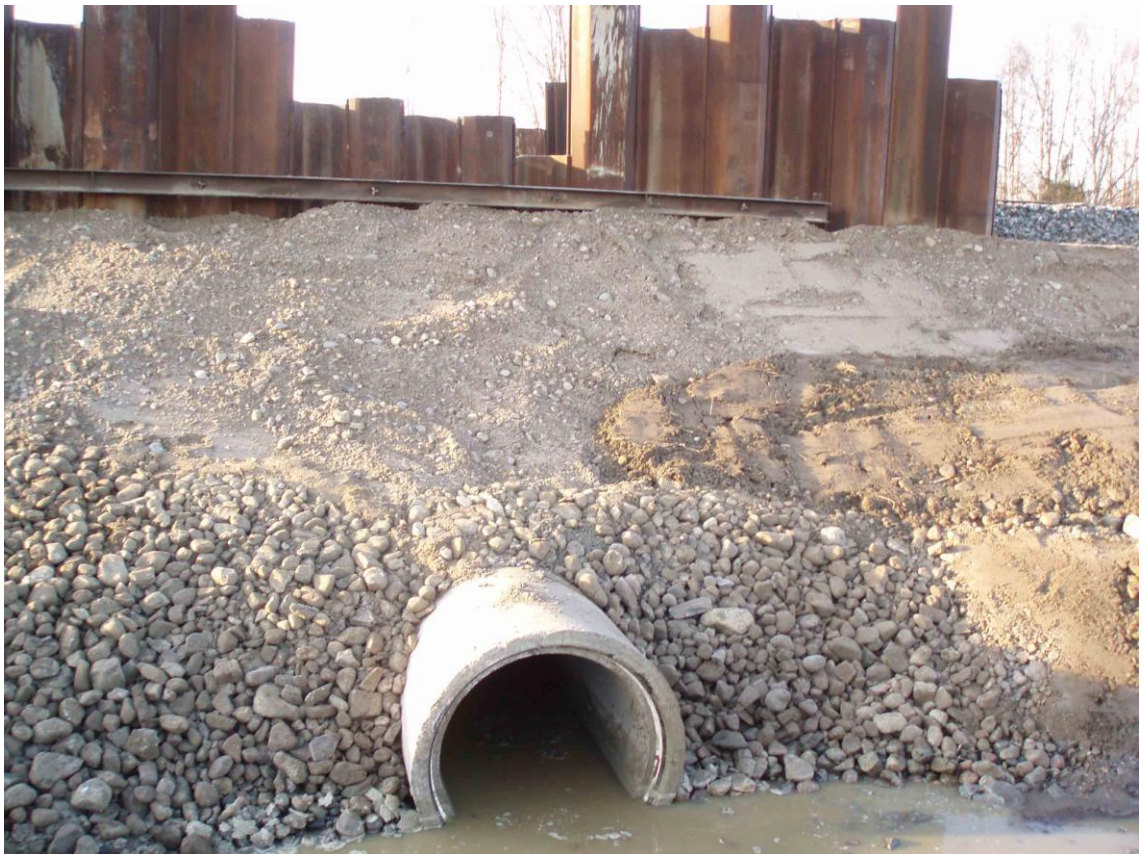
KUVA 4. Rummun jatkaminen betoniputkella
