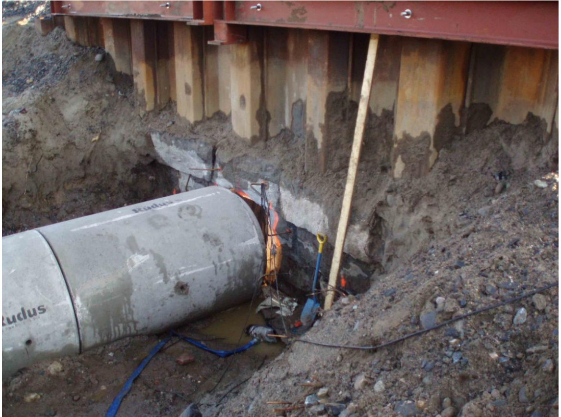
KUVA 6. Kivirummun jatkaminen betoniputkielementeillä
