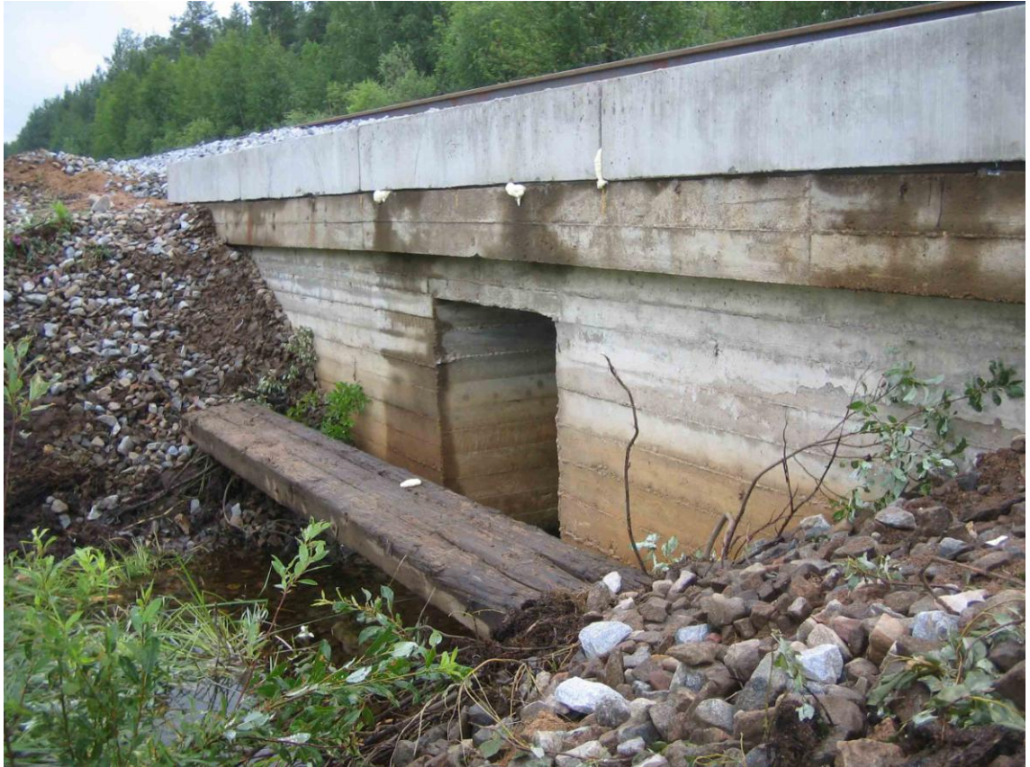
KUVA 7. Betonirumpu, jossa kaapelikanavakourulla toteutettu reunapalkkikorotus
