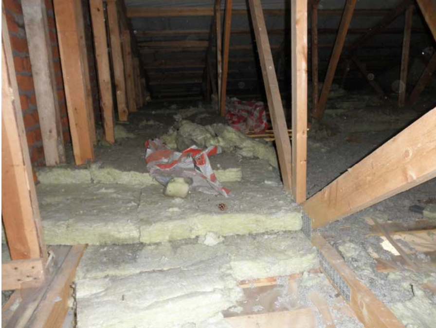
KUVA 9. Mineraalivilla yläpohjaeristeenä
