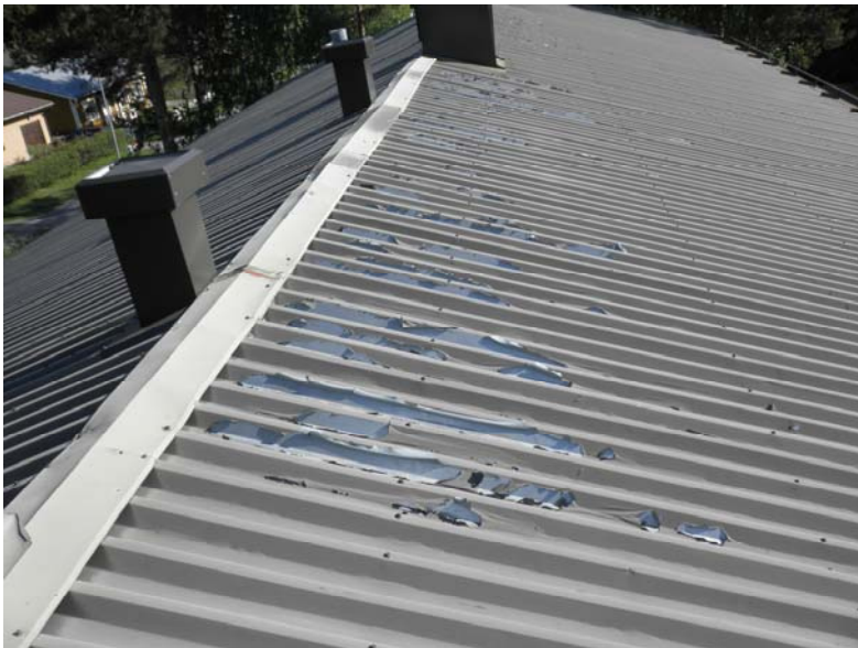
KUVA 4. Hilseilevä vesikatto
