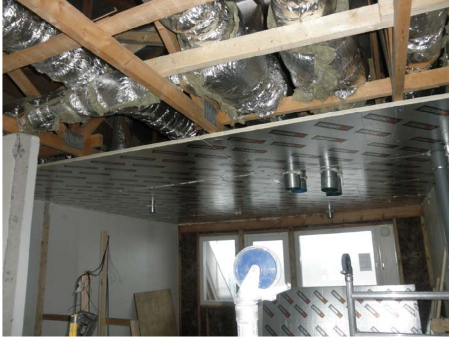
KUVA 11. Yläpohjan uusien rakennesuunnitelmien mukainen polyuretaanilevy
