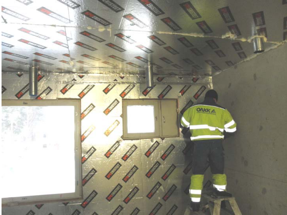
KUVA 12. SPU-eristeen saumojen ja läpivientien eristys uretaanivaahdolla
