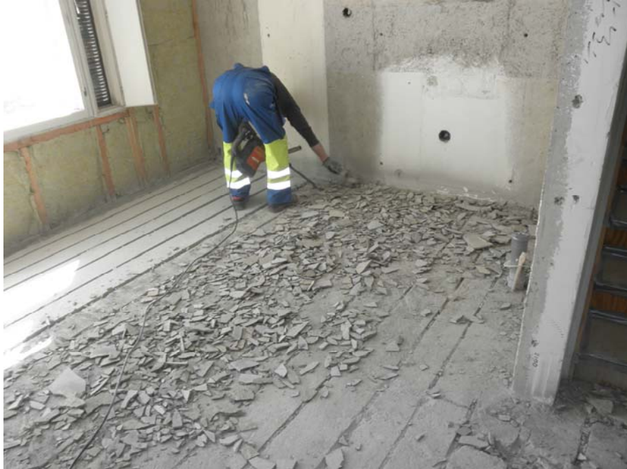
KUVA 23. Uritettu ja piikattu alapohjalaatta
