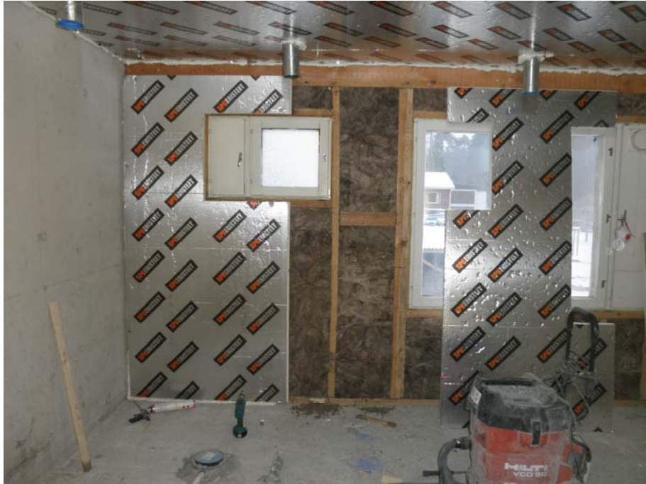
KUVA 18. Uusi ulkoseinärakenne
