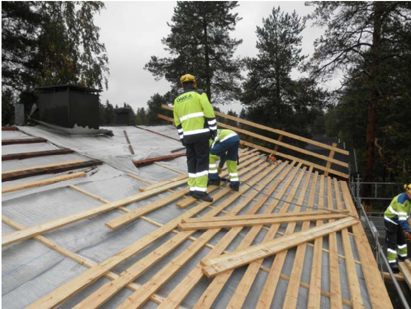
KUVA 7. Aluskatteen oikeaoppinen asennus
