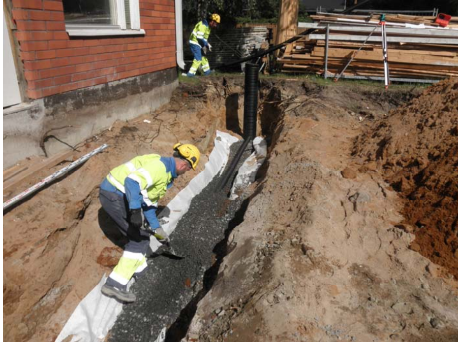
KUVA 28. Salaojajärjestelmän asennus
