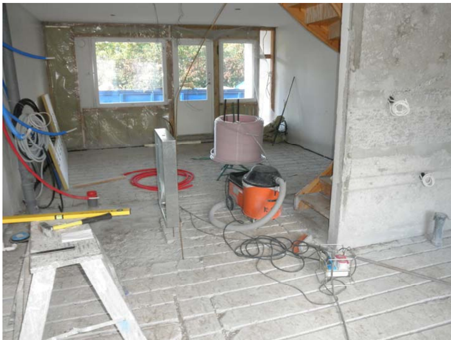
KUVA 24. Vesikiertoisen lattialämmityksen putkiston urat alapohjalaatassa
