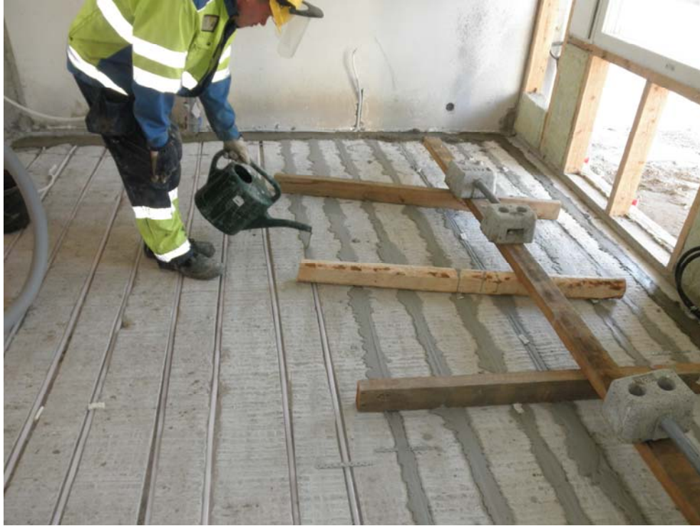
KUVA 26. Lattialämmityspotkiston juotosvalu
