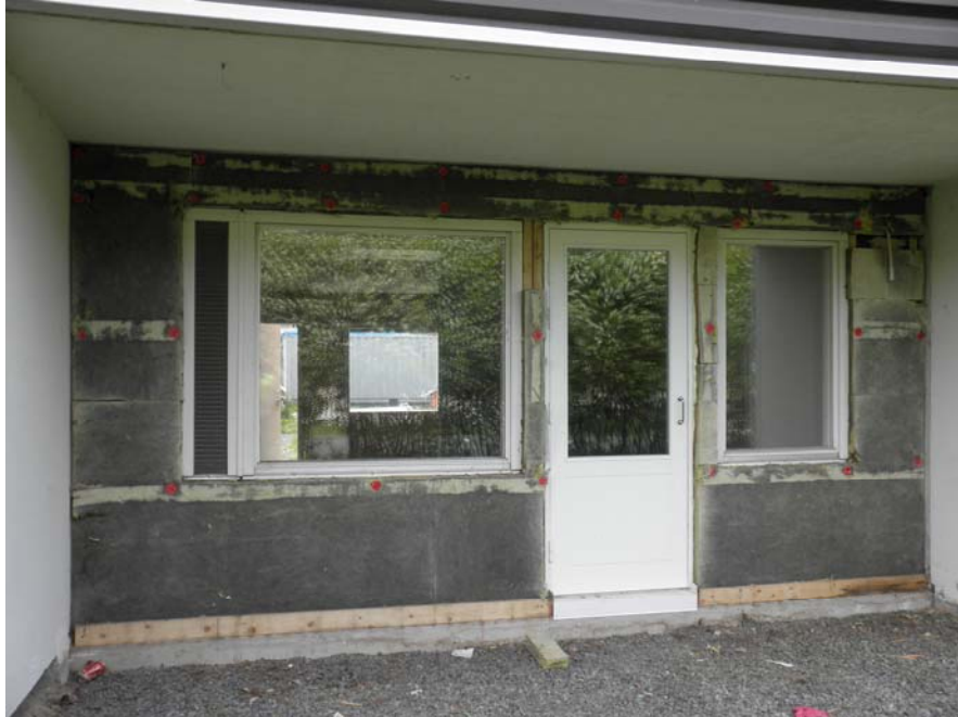
KUVA 16. Tummunut tuulensuojavilla
