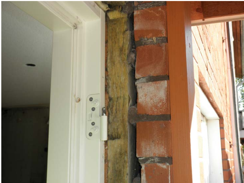
KUVA 17. Tukkeutunut tuuletusrako
