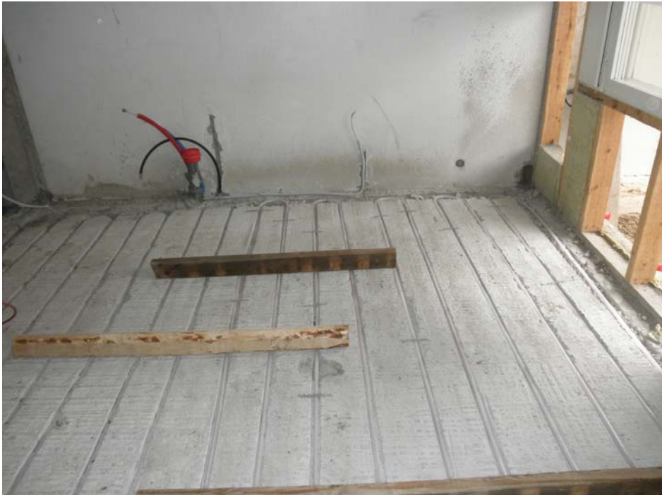
KUVA 25. Asennettu vesikiertoinen lattialämmitys
