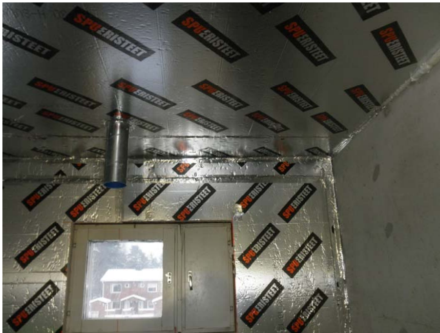
KUVA 13. SPU-eristeen saumojen ja läpivientien teippaus
