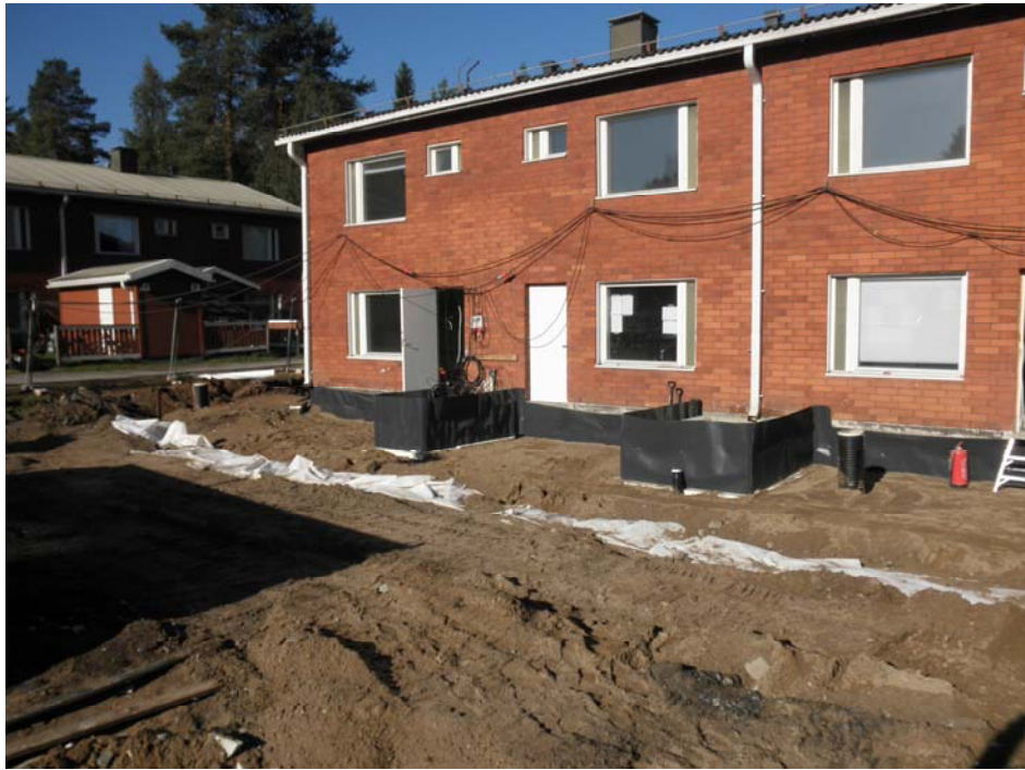
KUVA 29. Asennettu perusmuurilevy
