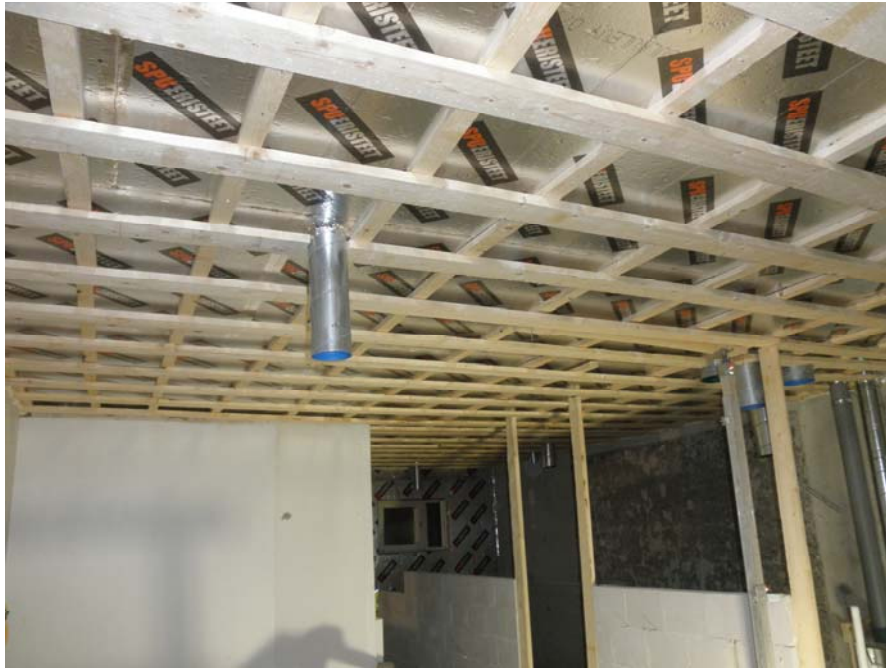
KUVA 14. Yläpohjan ristikoolaus
