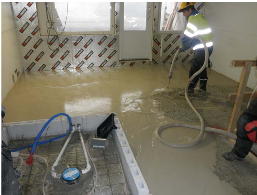
KUVA 21. Välipohjalaatan tasoitekerroksen valu
