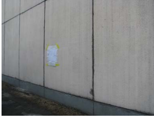
KUVA 41. Mittausruudukko teipattuna sandwich-elementtiin
