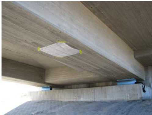
KUVA 67. Jännitetyn palkin alapinta
