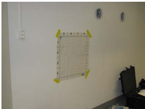
KUVA 36. Toimistorakennuksen väestönsuojan seinä
