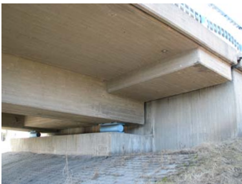
KUVA 63. Jännitetty laattapalkkisilta
