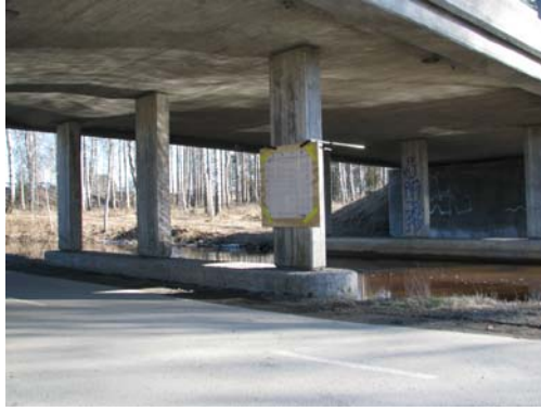
KUVA 60. Laattasillan pilari
