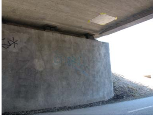
KUVA 57. Laattasillan kannen alapinta
