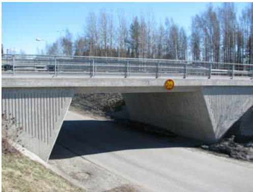
KUVA 50. Vinojalkainen kehäsilta
