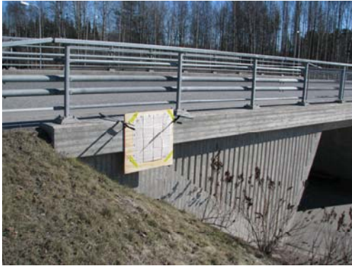
KUVA 54. Vinojalkaisen kehäsillan reunapalkki
