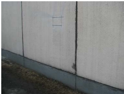
KUVA 46. Näytteenotto sandwich-elementistä
