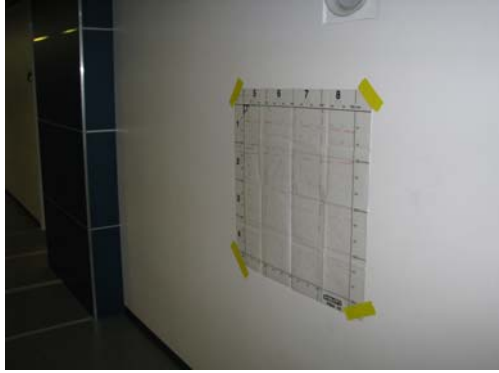
KUVA 38. Oppilaitoksen väestönsuojan seinä
