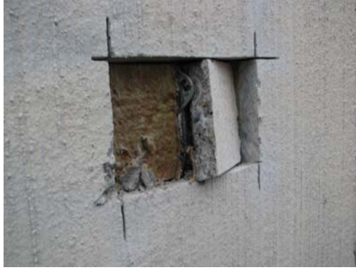
KUVA 47. Näytteenotto sandwich-elementistä
