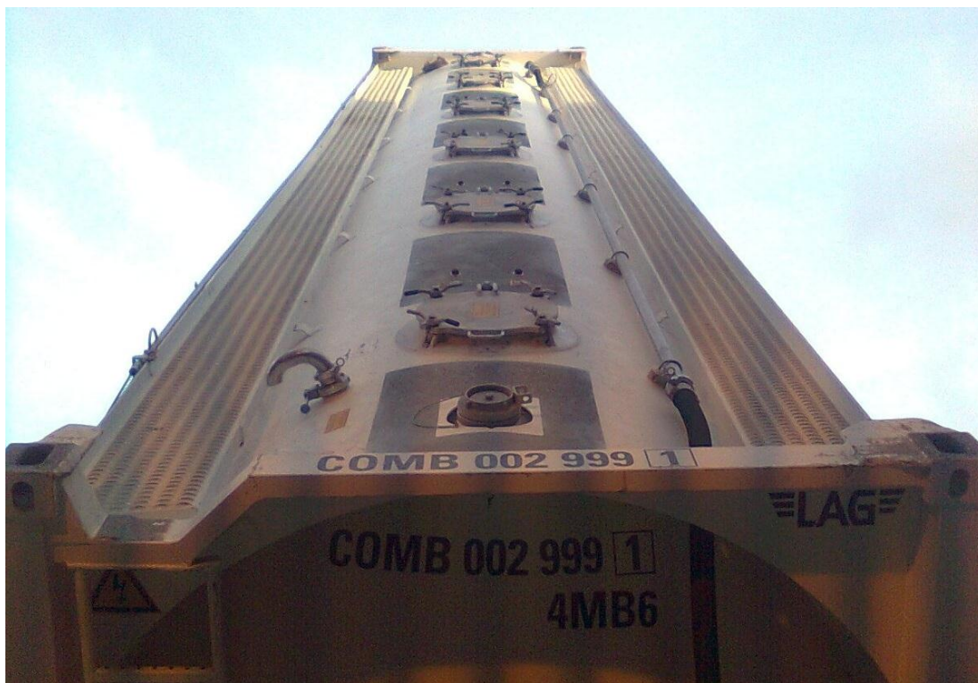
Kuva 16. Katon täyttöaukot ja kävelysillat (Kuva: J. Reinisalmi).
