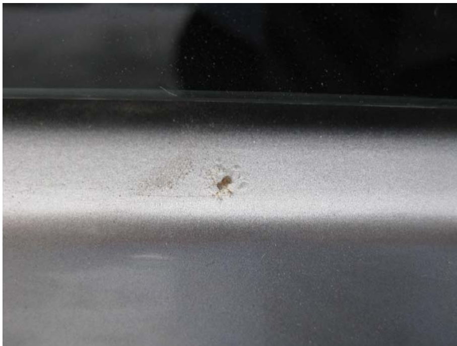
Kuva 6. Ulkoisen aiheuttajan aiheuttama maalipinnan vaurio.
