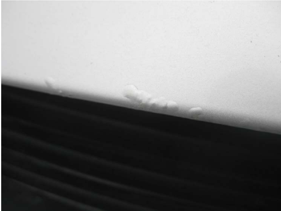
Kuva 7. Mahdollinen takuun piiriin kuuluva maalipinnan vaurio.
