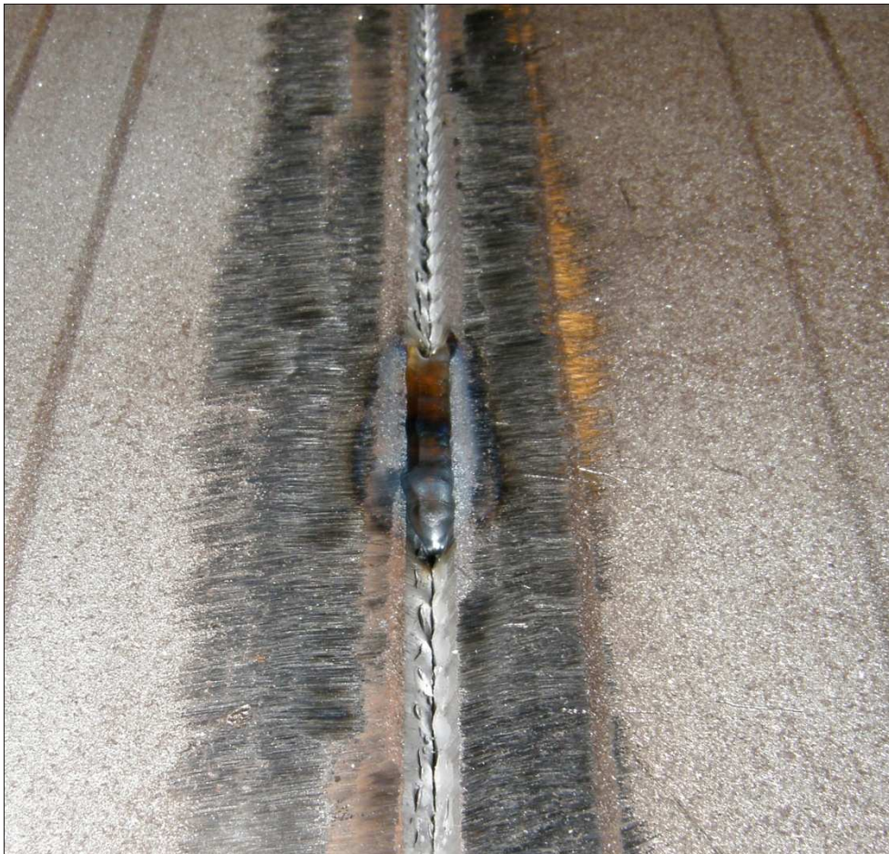
Kuva 21. 10 mm paksun levyn Y-railoon tehdystä silloitushitsistä.
