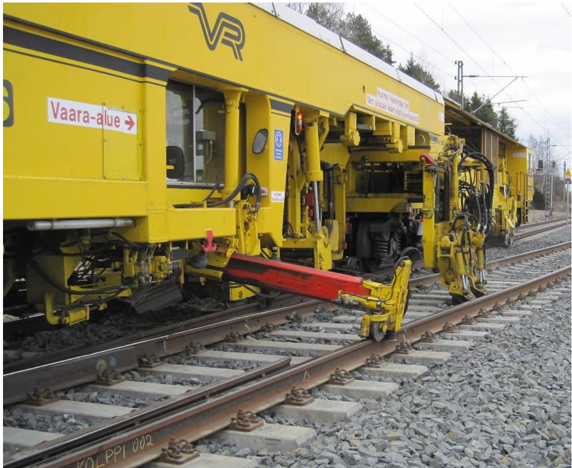
Vaihteentukemiskone Plasser & Theurer 08-475 4S risteyskohdalla. Tukemisaggregaatti ja nostokoukku kolmen kiskon nostoasennossa.
