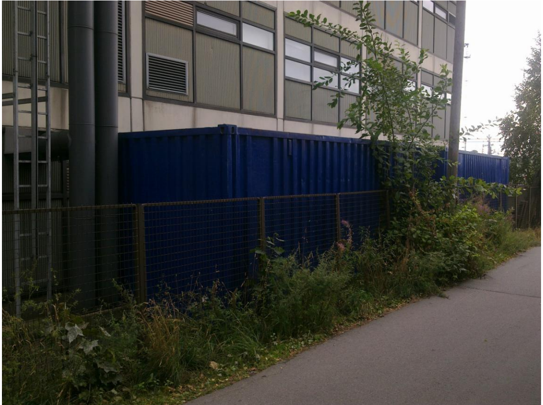
KUVA 3. Merikontit asetinlaitteen ulkopuolella
