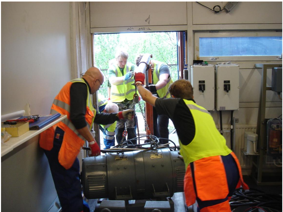
KUVA 5. Muuttajakoneen siirto käynnissä
