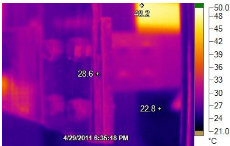
Kuva 1. Hapettunut liitos puhdistettuna ja kuparitahnalla käsiteltynä. Altaan kaikki virtakiskojen liitokset ovat kiristetty normaalisti. 3000 A (Kuva: Kalle Mononen)
