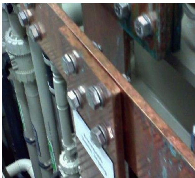
Kuva 10. Ilmarako liitoksessa (Kuva: Kalle Mononen)
