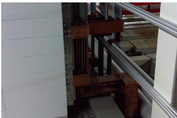
Kuva 8. Tasasuuntaajan 317 takapuoli (Kuva: Kalle Mononen)
