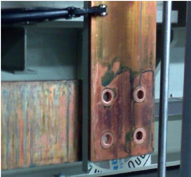
Kuva 11. Liitoksen eristys PP-levyllä (Kuva: Kalle Mononen)
