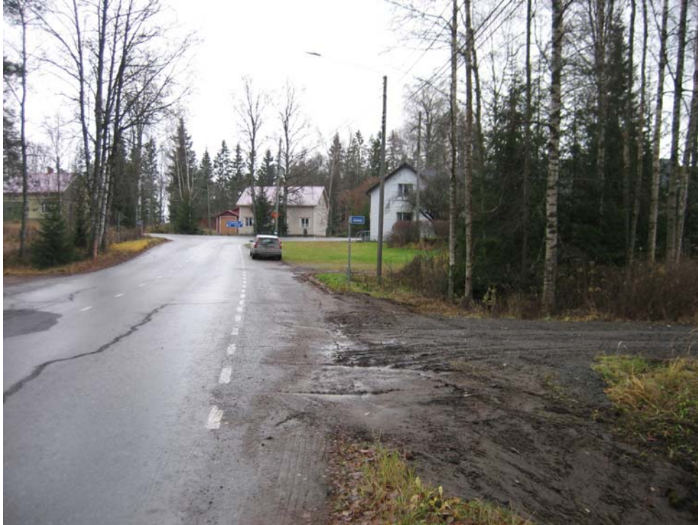
KUVA 3. Maantiellä 2470 liittymän pohjoispuolella on pitkittäishalkeamaa (Kuva: Annika Jalonen 2010)
