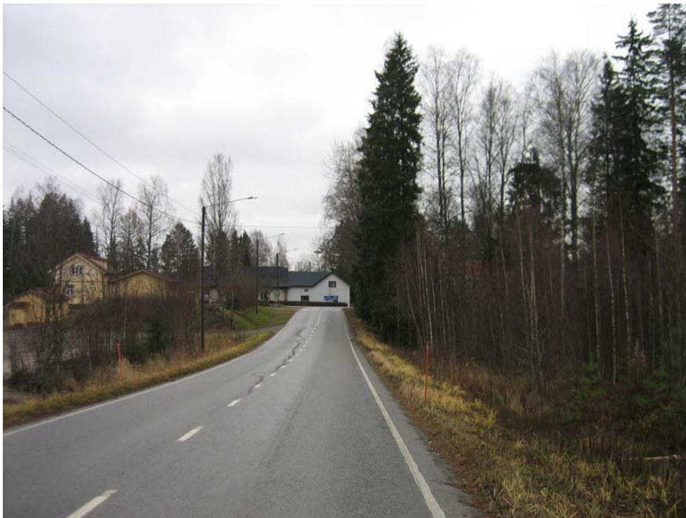
KUVA 4. Maantiellä 2470 liittymän eteläpuolella on keskihalkeamaa (Kuva: Annika Jalonen 2010)
