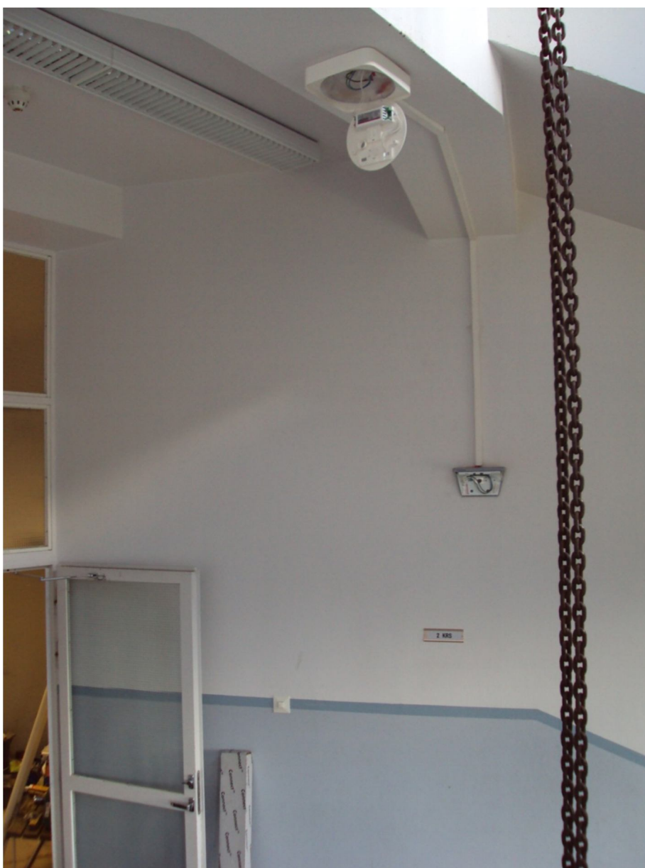
Kuva 24. Asennuksissa käytetty valkoinen muovikouru
